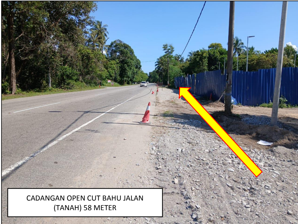
GAMBAR 3 : KAWASAN KERJA MELIBATKAN PEMOTONGAN BAHU JALAN (TIDAK BERTAR) (DARI DUNGUN KE BANDAR MARANG)
