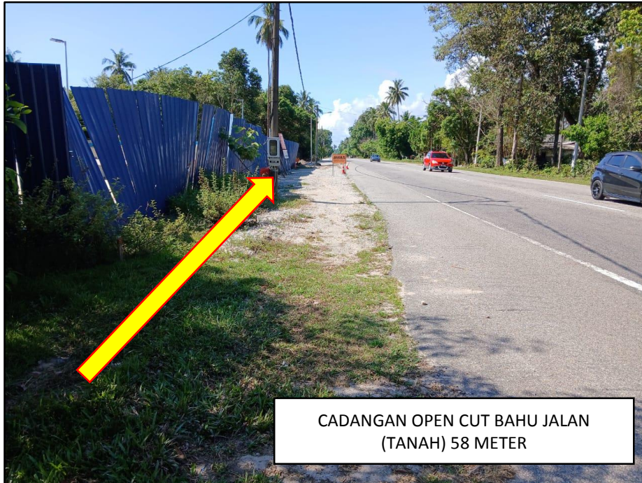
GAMBAR 1 : KAWASAN KERJA MELIBATKAN PEMOTONGAN BAHU JALAN (TIDAK BERTAR) (DARI BANDAR MARANG KE DUNGUN)
