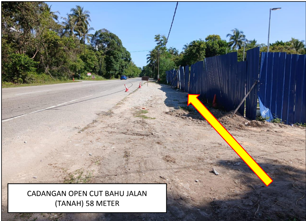
GAMBAR 4 : KAWASAN KERJA MELIBATKAN PEMOTONGAN BAHU JALAN (TIDAK BERTAR) (DARI DUNGUN KE BANDAR MARANG)
