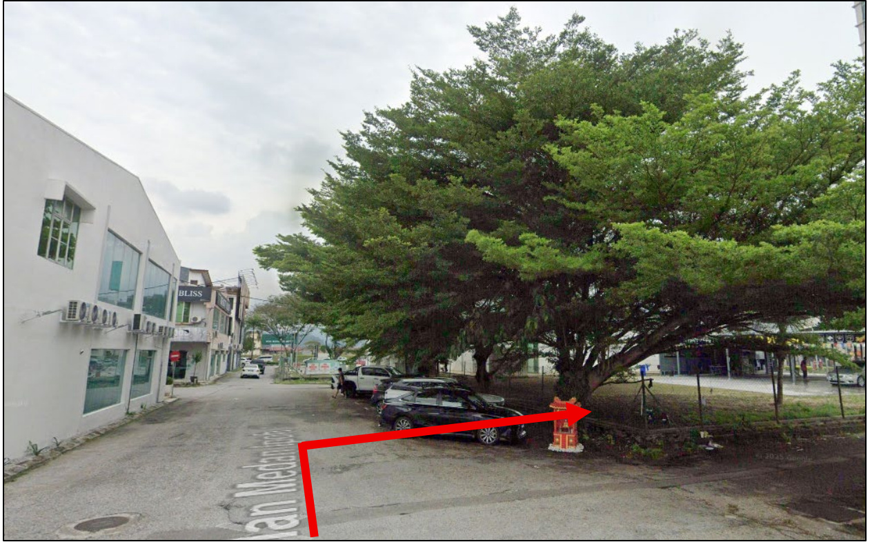
Gambar 5: Kawasan Kerja Melibatkan Pemotongan Jalan (Open Cut)
