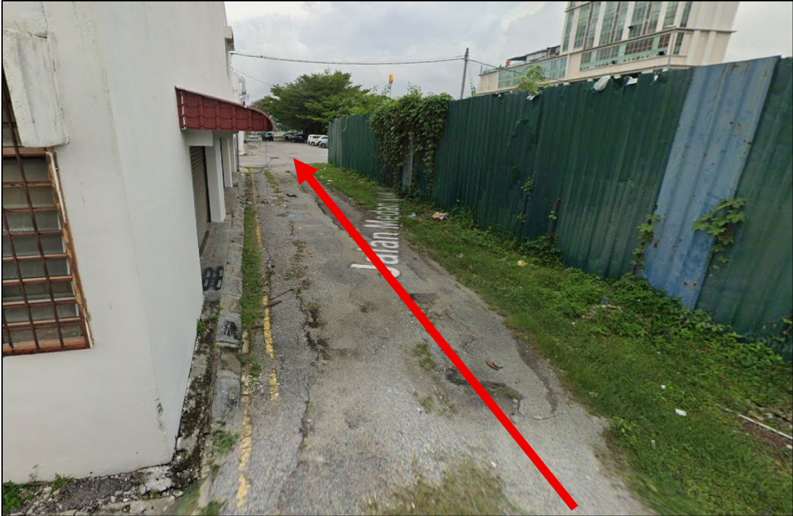
Gambar 3: Kawasan Kerja Melibatkan Pemotongan Jalan (Open Cut)
