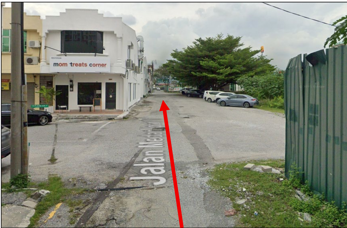
Gambar 4: Kawasan Kerja Melibatkan Pemotongan Jalan (Open Cut)
