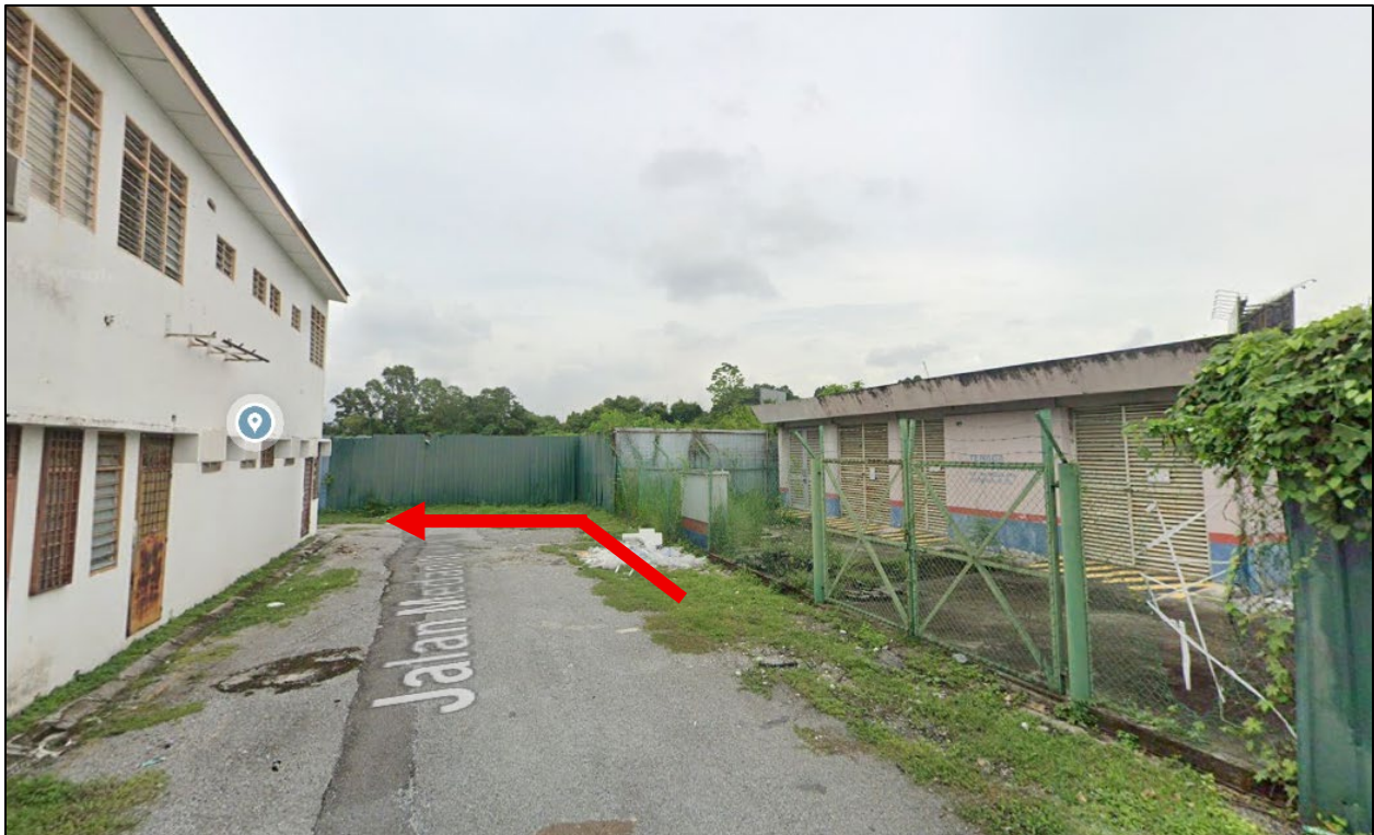
Gambar 2: Kawasan Kerja Melibatkan Pemotongan Jalan ( Open Cut )
