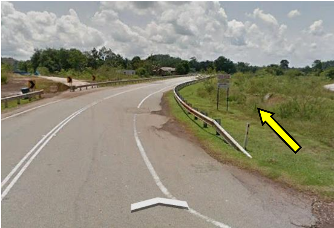
Laluan kanan jalan
