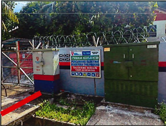
PENCAWANG ELEKTRIK KUARTERS TNB REDANG
