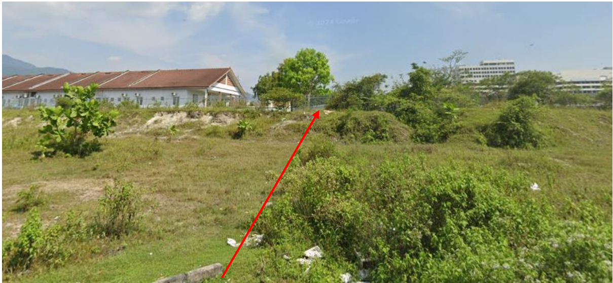
KERJA – KERJA OPEN CUT JALAN TIDAK BERTURAP (44M) JALAN KAMPAR BARAT (4.321905, 101.130823, 4.321576, 101.13086)
