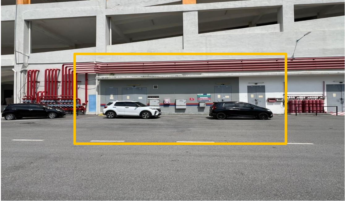
TITIK AKHIR LALUAN KABEL DI JALAN PEMAJU ( 4.317961, 101.131615 )
