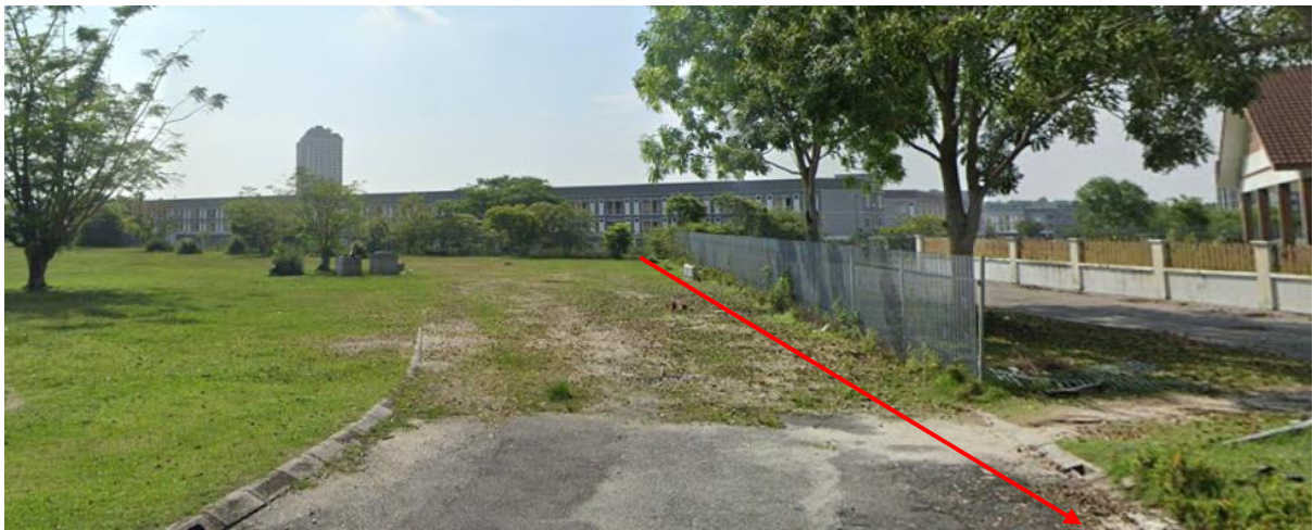
KERJA – KERJA OPEN CUT JALAN TIDAK BERTURAP (58M) JALAN PUTRA BERLIAN (4.321576, 101.13086, 4.321394, 101.131271)
