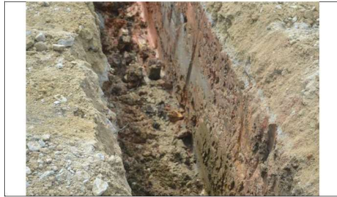
Lapisan tar, crusher run dan pasir dibuang menggunakan lori ke tempat yang dibenarkan oleh PBT.
