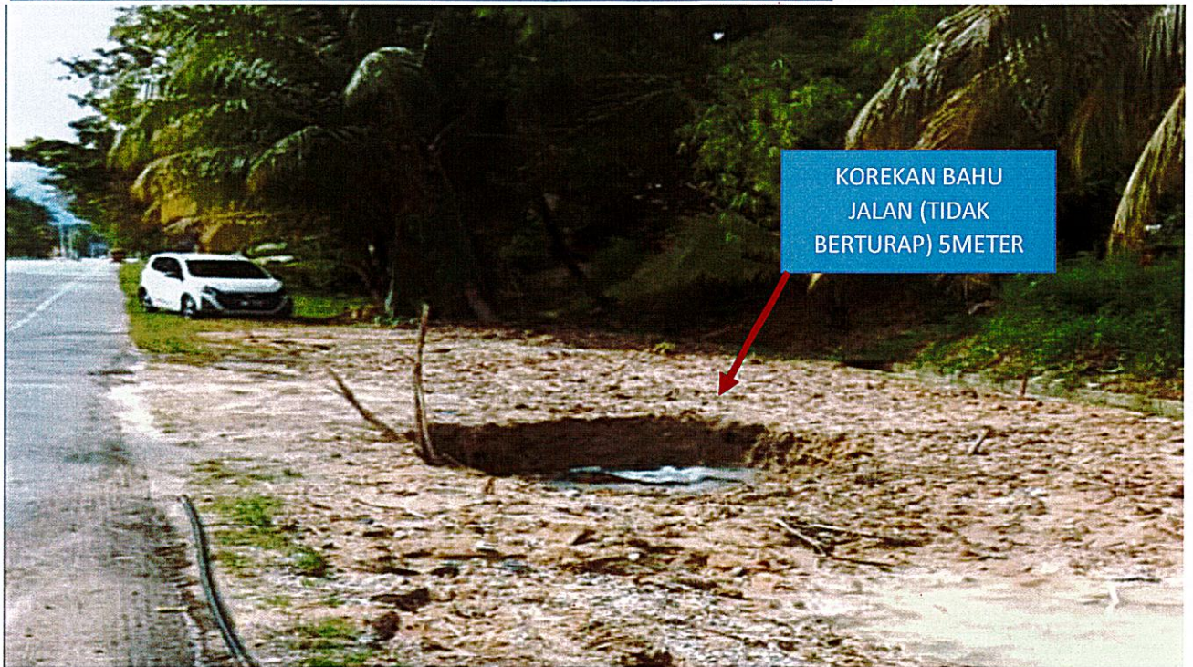
GAMBAR 1: KAWASAN KERJA PENUKARAN PAIP PEMBETUNGAN AWAM PECAH DAN ROSAK DI BAHU JALAN (TIDAK BERTURAP)- OPEN CUT.
