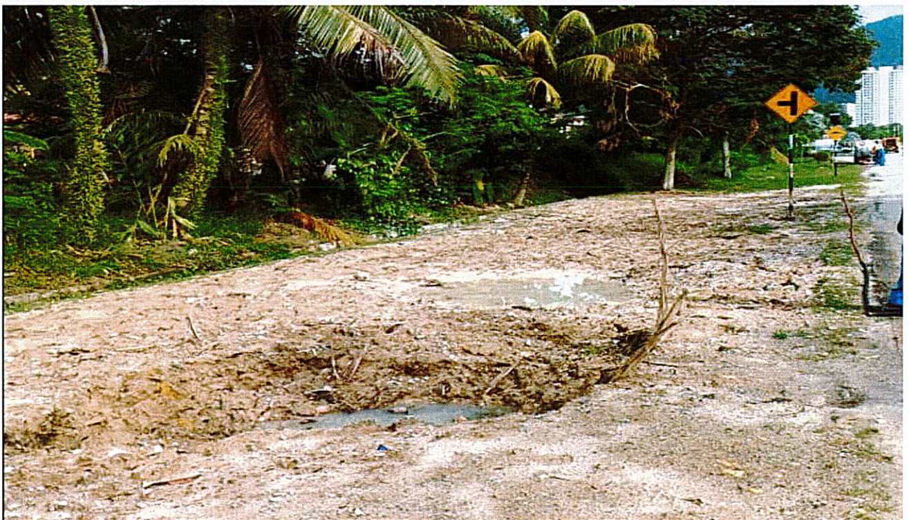
GAMBAR 2: KAWASAN KERJA PENUKARAN PAIP PEMBETUNGAN AWAM PECAH DAN ROSAK DI BAHU JALAN (TIDAK BERTURAP)- OPEN CUT.
