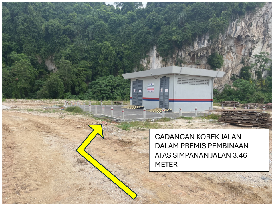
GAMBAR 8 : KAWASAN KERJA YANG MELIBATKAN PENGOREKKAN JALAN (DALAM PREMIS TAPAK PEMBINAAN DI ATAS SIMPANAN JALAN) TERUS KE PENCAWANG ELEKTRIK BARU
