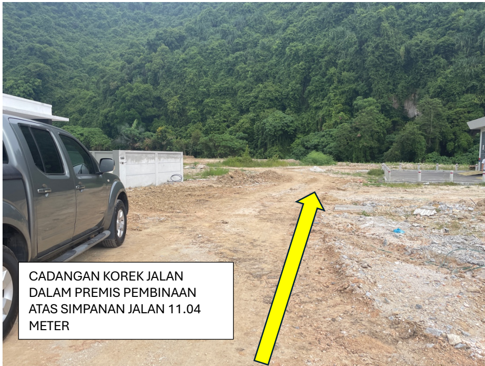
GAMBAR 7 : KAWASAN KERJA YANG MELIBATKAN PENGOREKKAN JALAN (DALAM PREMIS TAPAK PEMBINAAN DI ATAS SIMPANAN JALAN)
