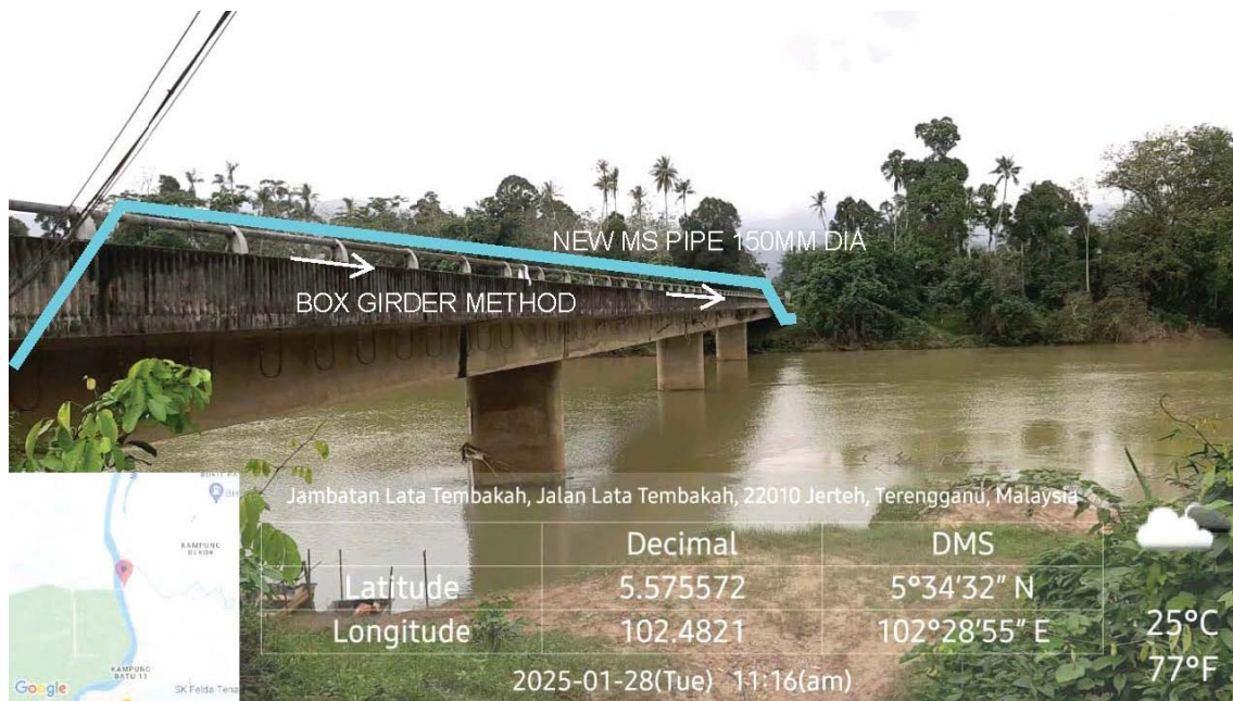
GAMBAR 3 : Kawasan cadangan laluan paip baru pada kawasan jambatan, kaedah box girder merentangi Sungai Besar.
