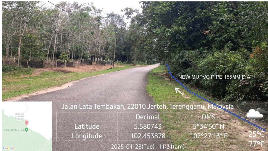
GAMBAR 8 : Kawasan cadangan laluan paip baru pada laluan tepi jalan.
