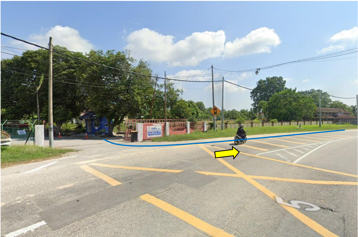
GAMBAR 1: KAWASAN KERJA MELIBATKAN 'HORIZONTAL DIRECTIONAL DRILLING'
