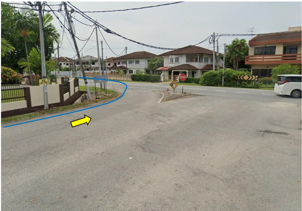
GAMBAR 8: KAWASAN KERJA MELIBATKAN 'HORIZONTAL DIRECTIONAL DRILLING'
