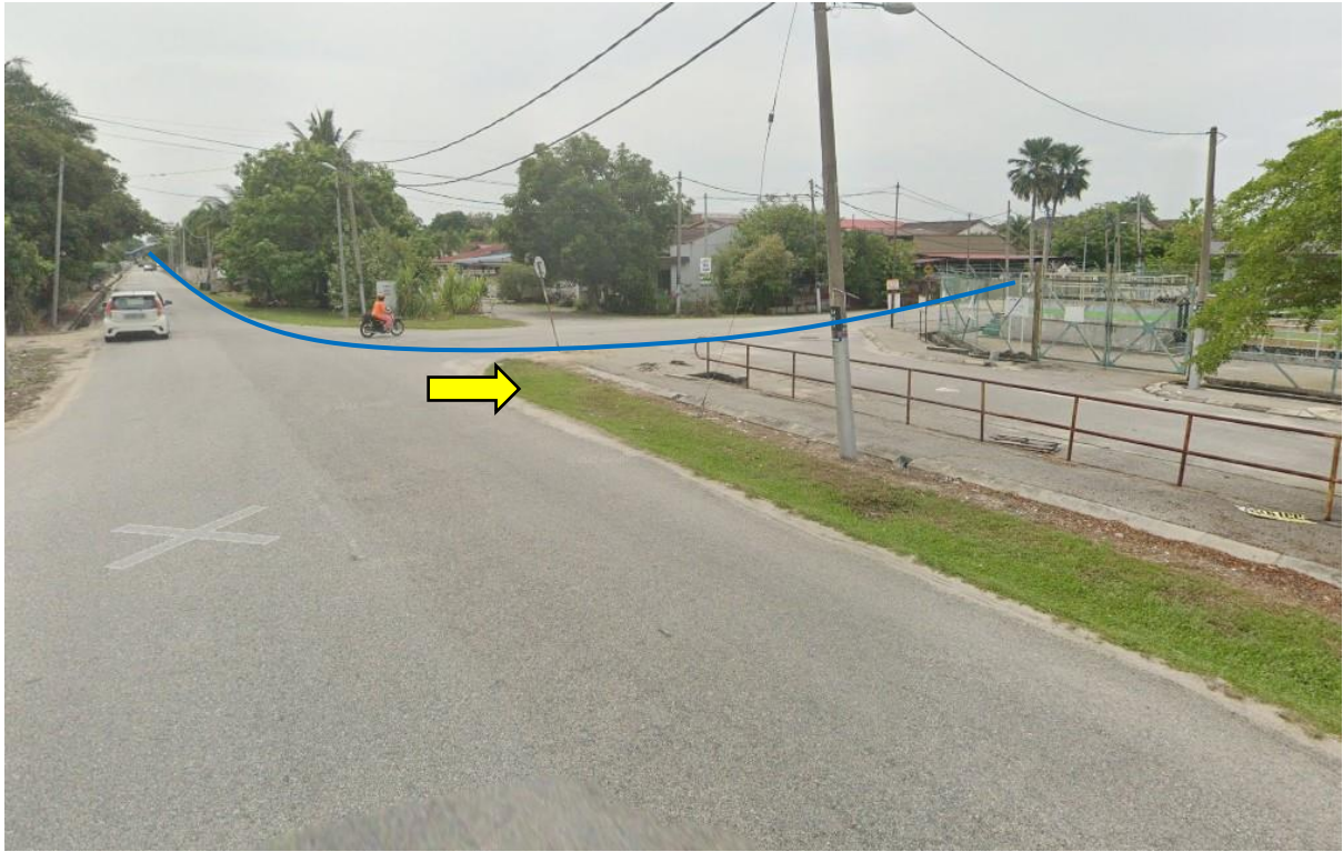
GAMBAR 7: KAWASAN KERJA MELIBATKAN 'HORIZONTAL DIRECTIONAL DRILLING'
