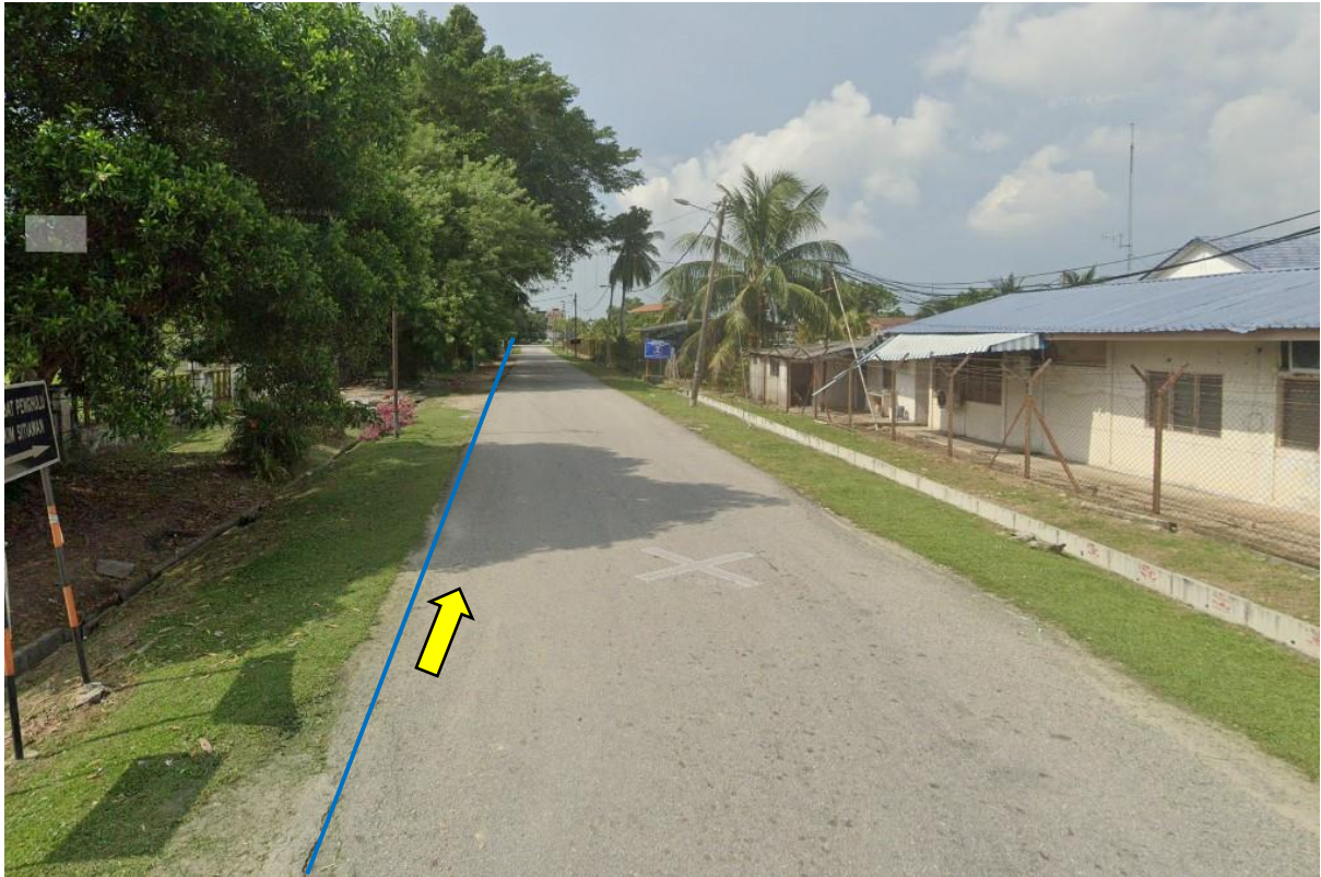
GAMBAR 3: KAWASAN KERJA MELIBATKAN 'HORIZONTAL DIRECTIONAL DRILLING'
