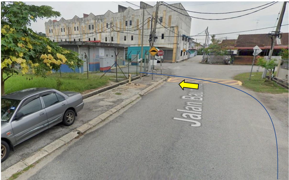
GAMBAR 10: KAWASAN KERJA MELIBATKAN 'HORIZONTAL DIRECTIONAL DRILLING'
