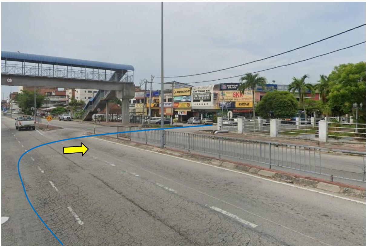
GAMBAR 6: KAWASAN KERJA MELIBATKAN 'HORIZONTAL DIRECTIONAL DRILLING'
