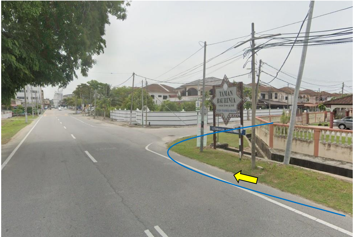
GAMBAR 9: KAWASAN KERJA MELIBATKAN 'HORIZONTAL DIRECTIONAL DRILLING'
