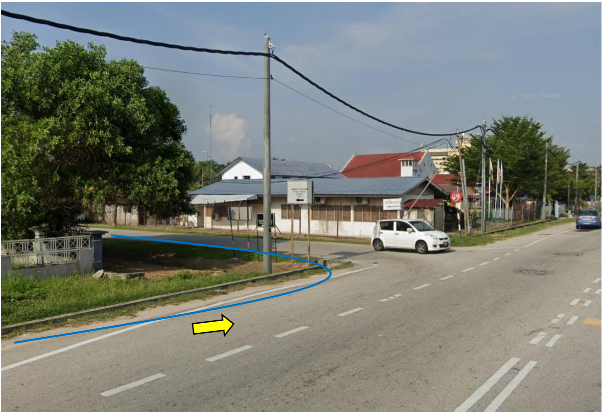
GAMBAR 2: KAWASAN KERJA MELIBATKAN 'HORIZONTAL DIRECTIONAL DRILLING'
