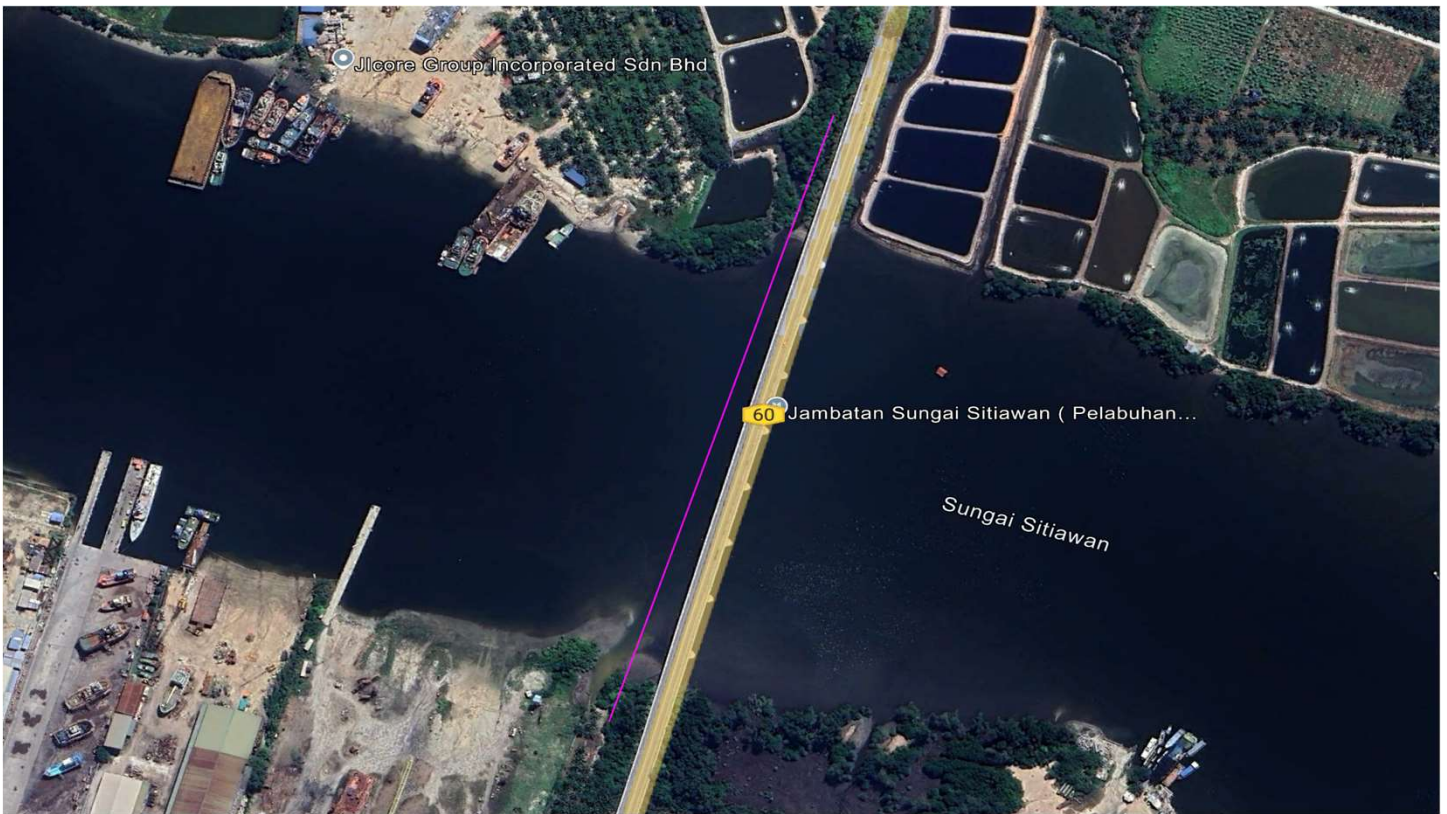
JAMBATAN 1 SUNGAI SITIAWAN (HDD)
