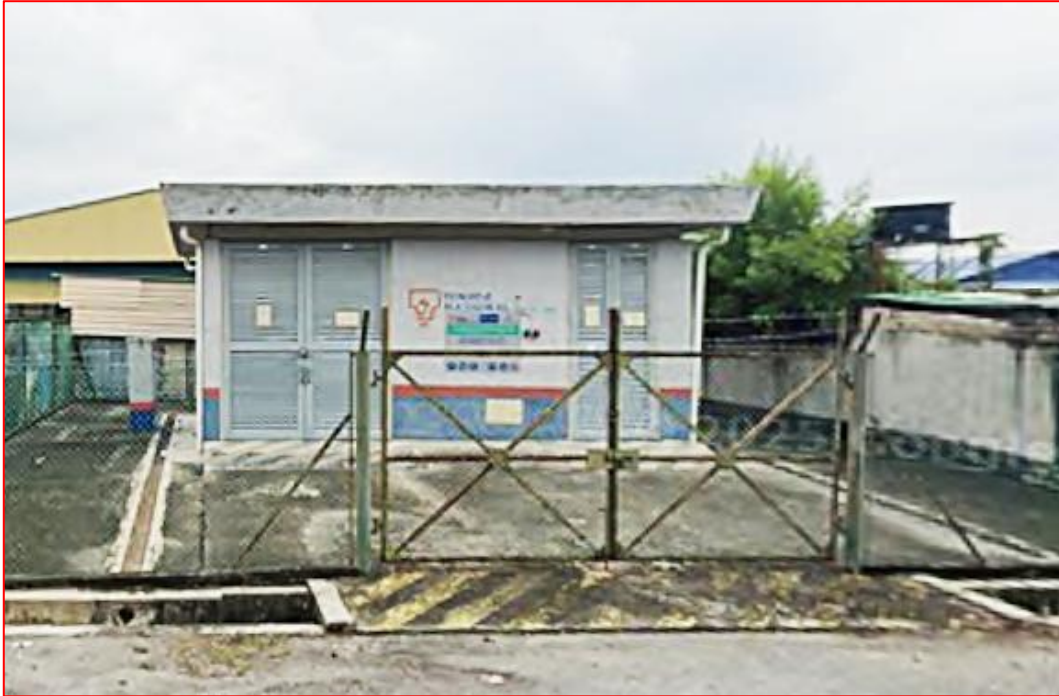
GAMBAR 1 : PENCAWANG SEDIA ADA (PENCAWANG ELEKTRIK IND. PENGKALAN 2)
