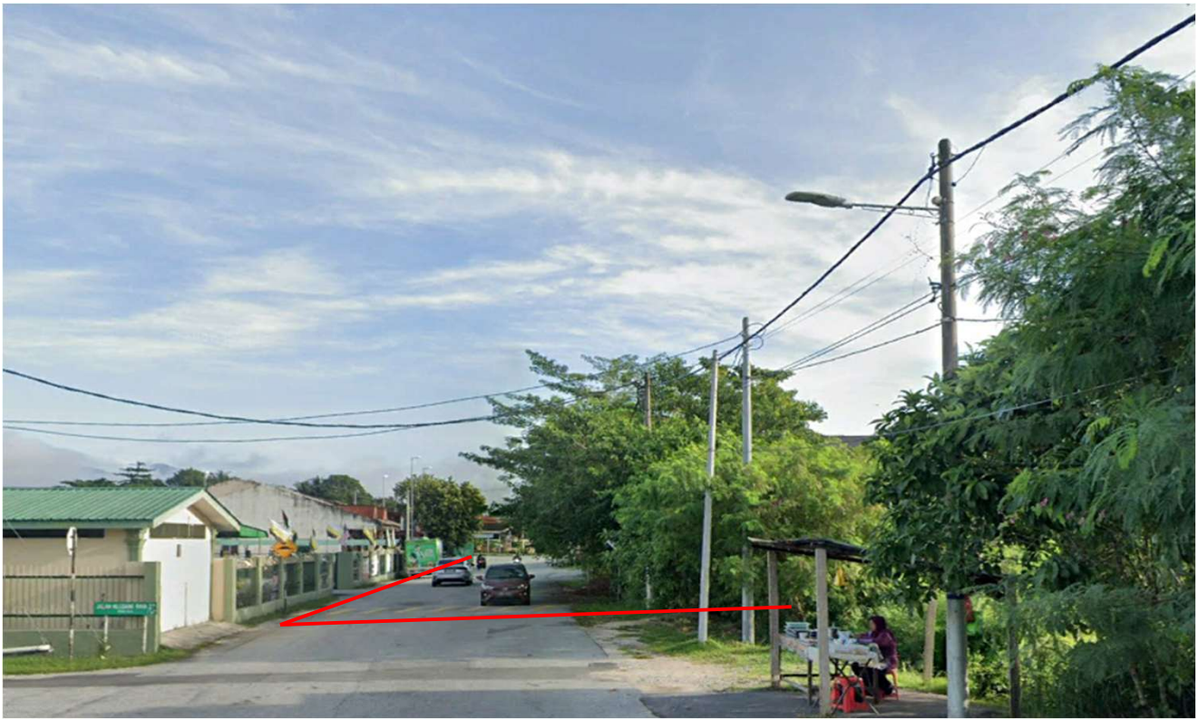
JALAN KLEDANG RAYA 22 (HDD)
