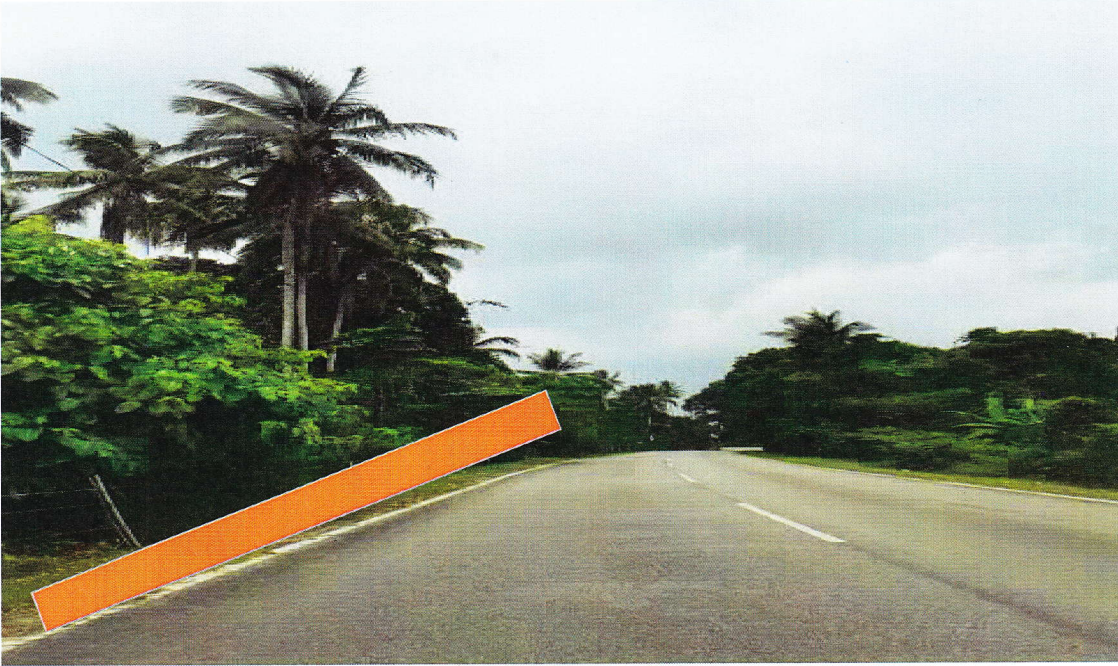
KAWASAN KERJA MELIBATKAN OPEN CUT DI ATAS JALAN BIASA
