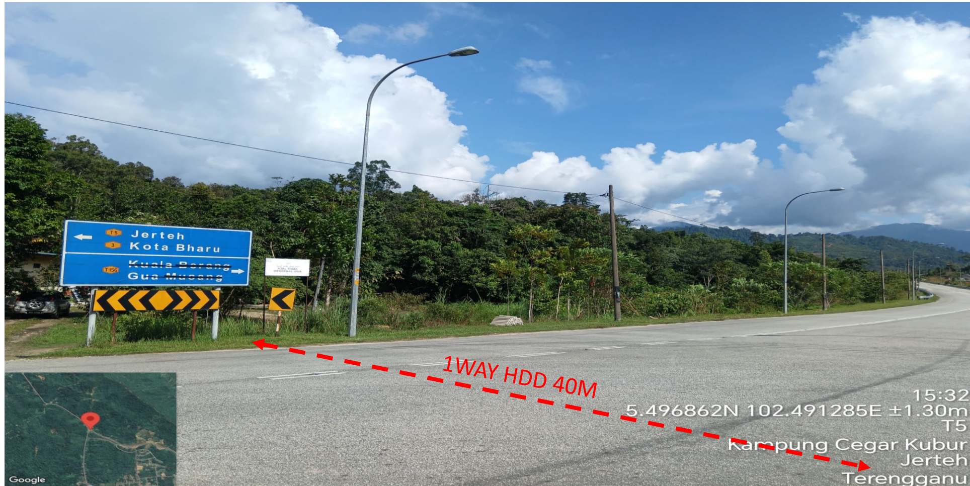
NEW 1WAY HDD JALAN T5 KG CENGAR KUBUR KERUAK BESUT
