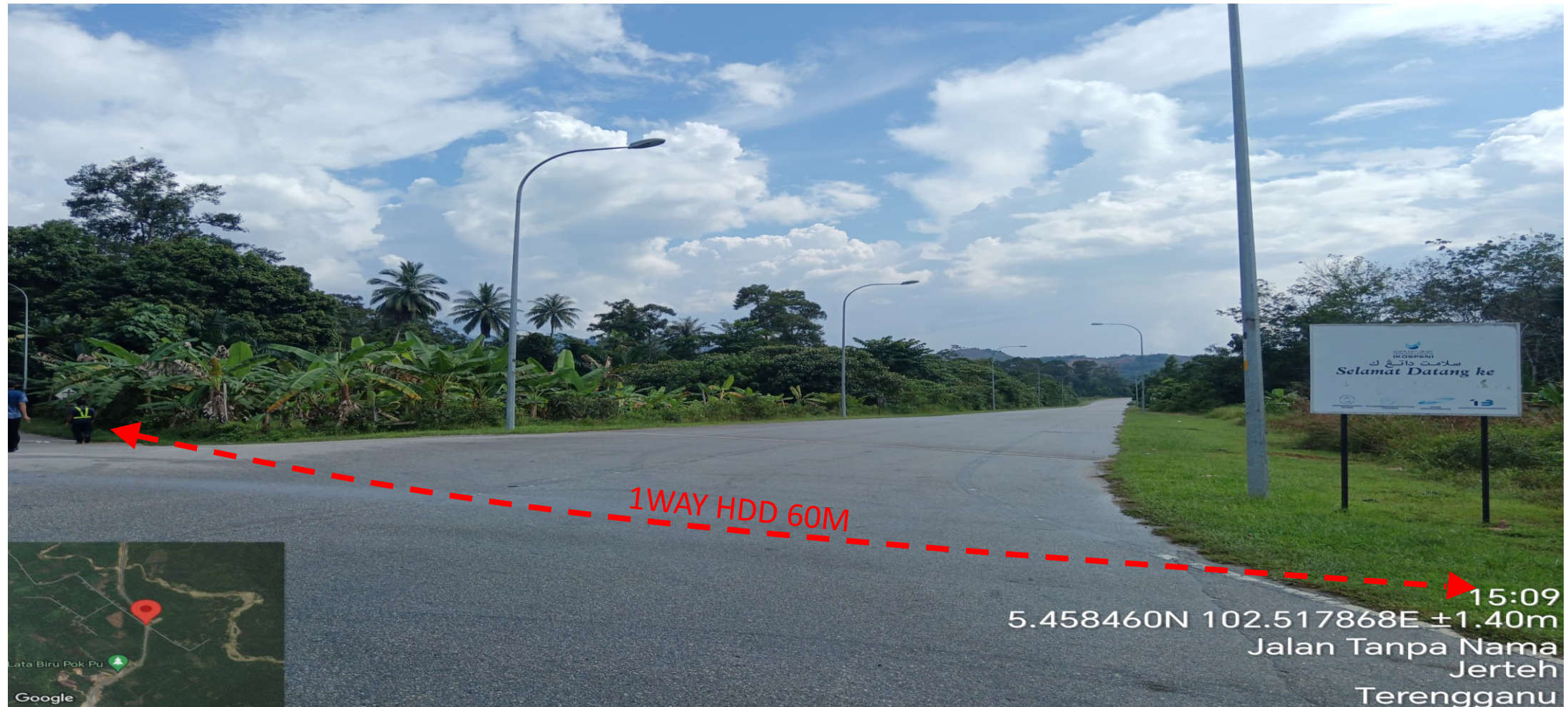
NEW 1WAY HDD JALAN TANPA NAMA KG PAK SIK KERUAK BESUT
