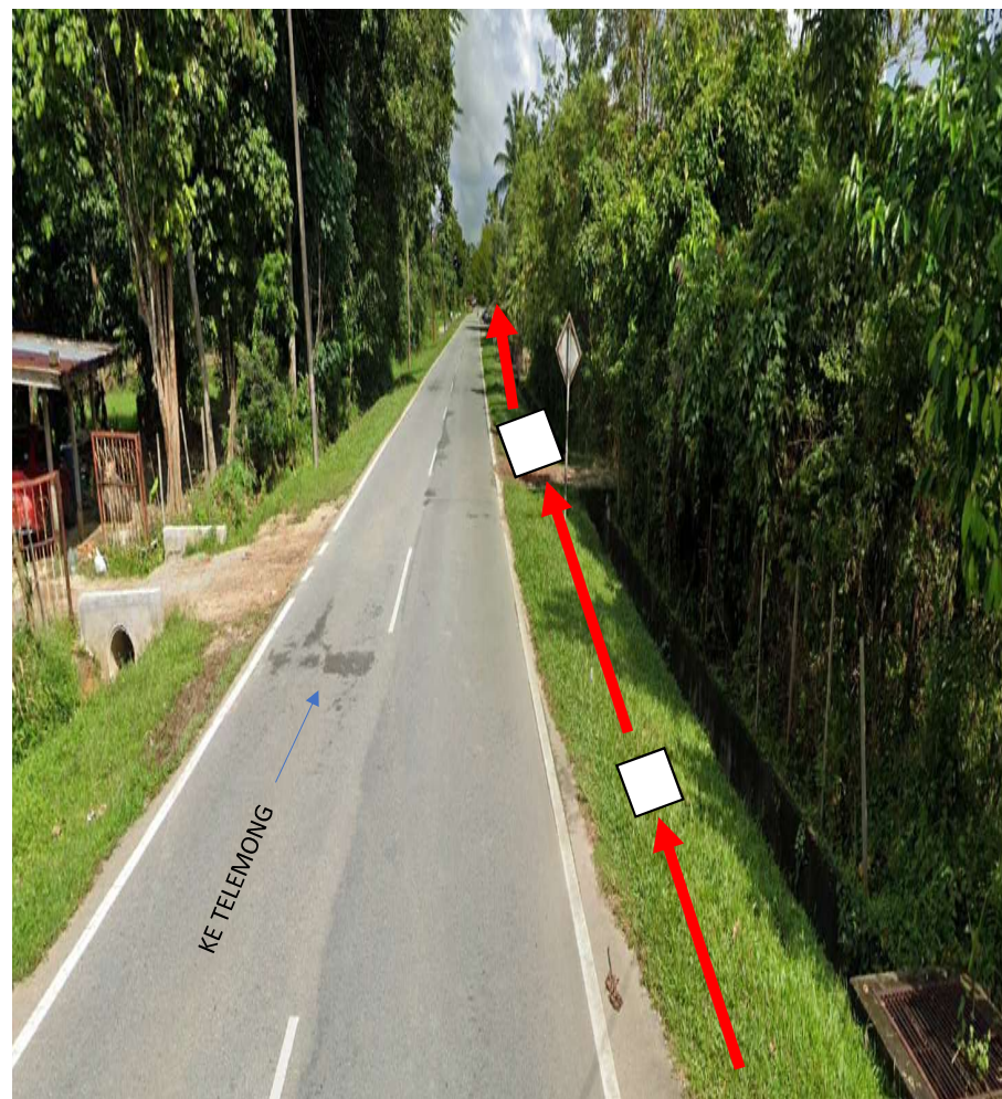
GAMBAR 2 : KAWASAN KERJA MELIBATKAN KERJA-KERJA TARIK KABEL UG
