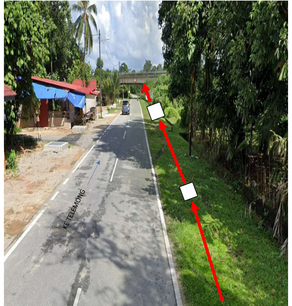
GAMBAR 4 : KAWASAN KERJA MELIBATKAN KERJA-KERJA TARIK KABEL UG
