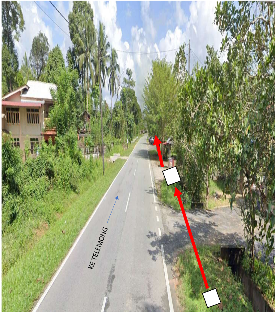
GAMBAR 3 : KAWASAN KERJA MELIBATKAN KERJA-KERJA TARIK KABEL UG
