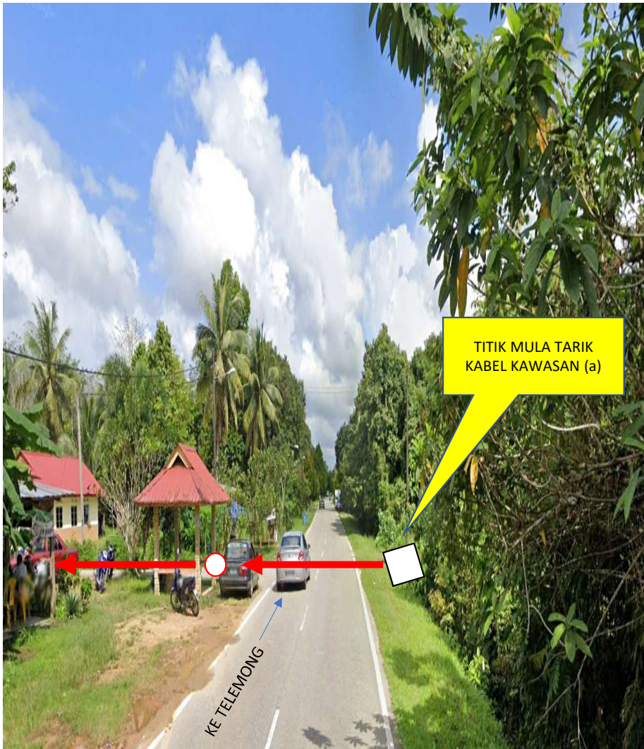
GAMBAR 7 : KAWASAN KERJA MELIBATKAN KERJA-KERJA TARIK KABEL 1B (a)
