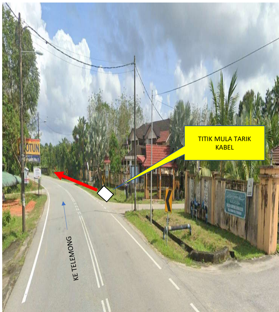
GAMBAR 1 : KAWASAN KERJA MELIBATKAN KERJA-KERJA TARIK KABEL UG DI HADAPAN MASJID SUNGAI ULAR, KUALA BERANG
