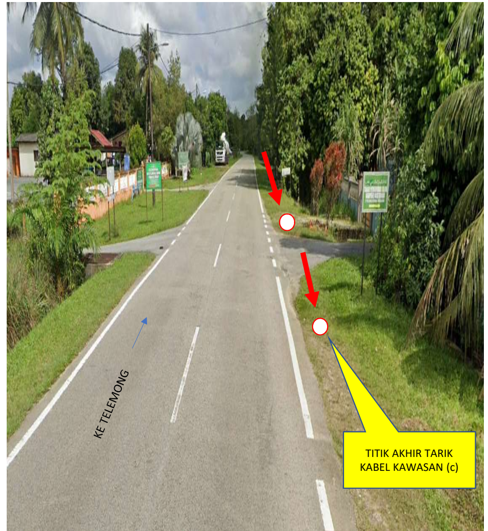
GAMBAR 10 : KAWASAN KERJA MELIBATKAN KERJA-KERJA TARIK KABEL IB (c)
