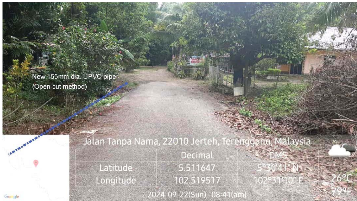
GAMBAR 5 : Kawasan cadangan laluan paip baru pada laluan tepi jalan.
