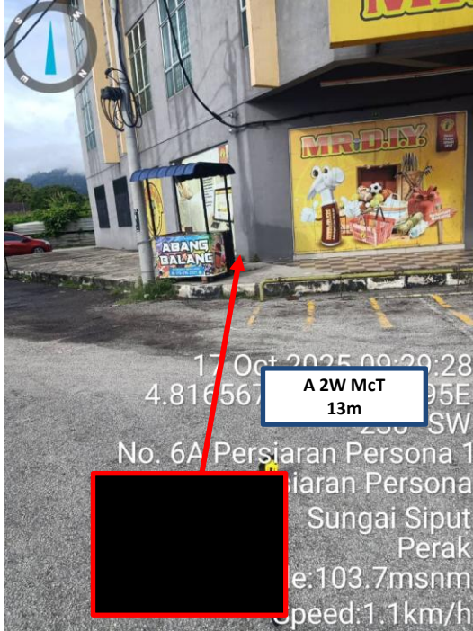
REDMARK: MCT DARIPADA PROPOSED NEW MANHOLE KE BANGUNAN KEDAI MR DIY
