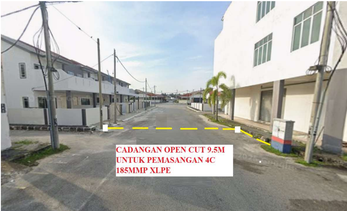
Gambar 4 : Kawasan Kerja Melibatkan Pemotongan Jalan (Open Cut)
