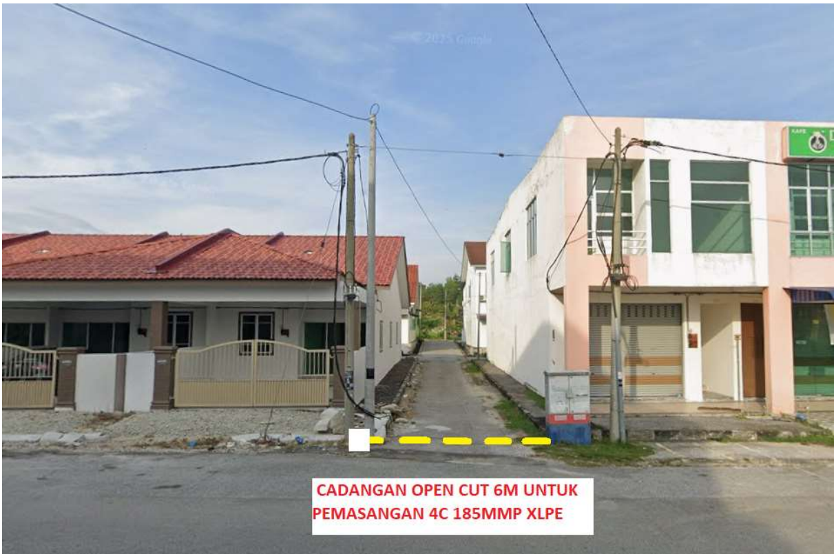
Gambar 2 : Kawasan Kerja Melibatkan Pemotongan Jalan (Open Cut)
