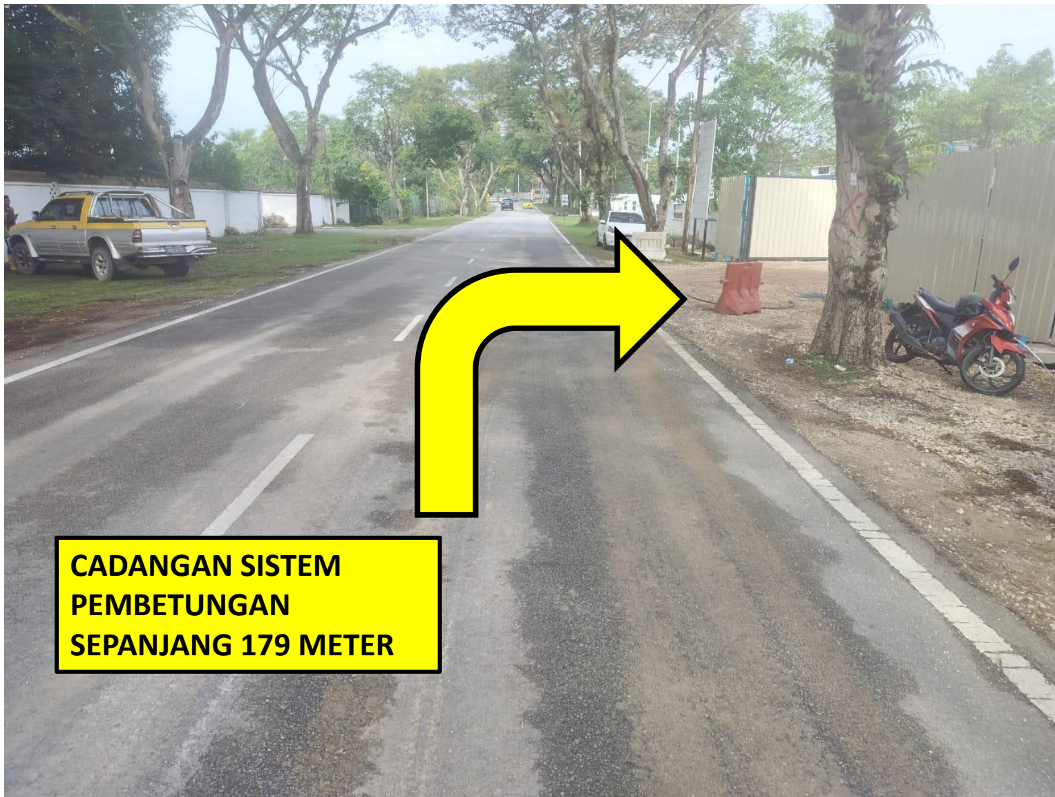
GAMBAR 5: KAWASAN KERJA MALIBATKAN KOREKAN JALAN BERTURAP
