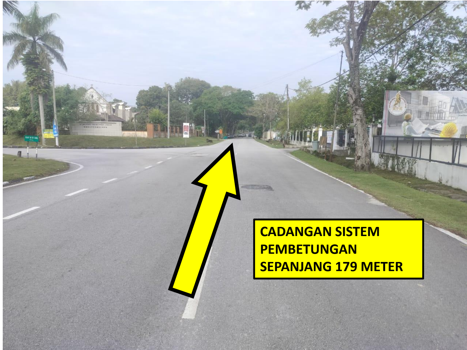
GAMBAR 1: KAWASAN KERJA MALIBATKAN KOREKAN JALAN BERTURAP
