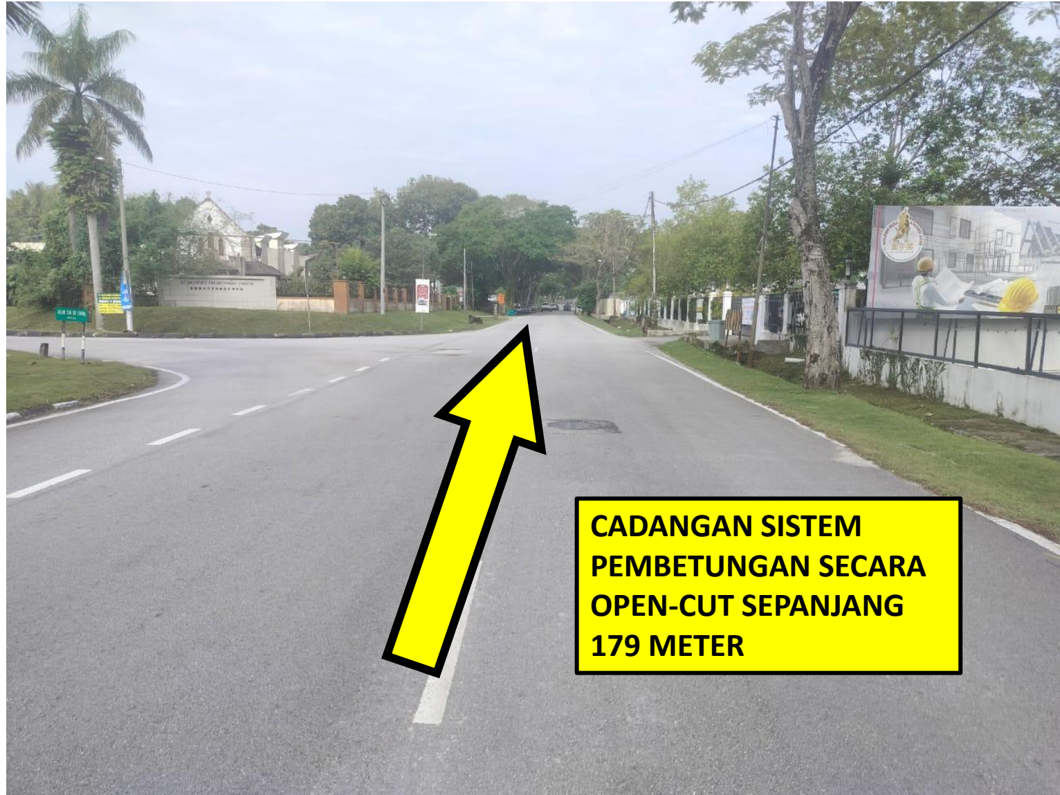
GAMBAR 1: KAWASAN KERJA MALIBATKAN KOREKAN JALAN BERTURAP
