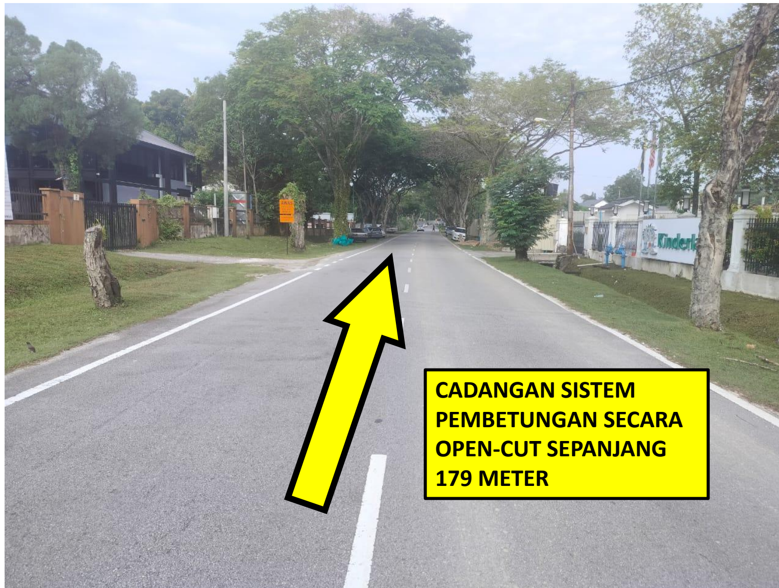
GAMBAR 3: KAWASAN KERJA MALIBATKAN KOREKAN JALAN BERTURAP
