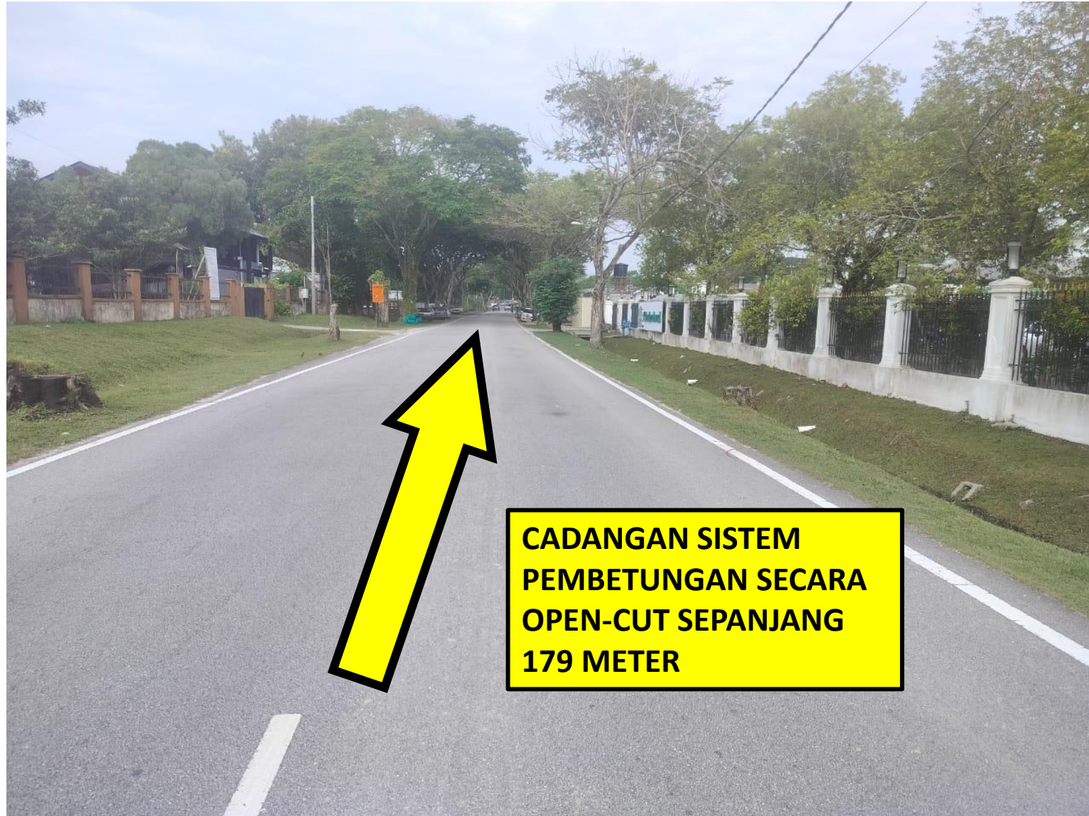
GAMBAR 2: KAWASAN KERJA MALIBATKAN KOREKAN JALAN BERTURAP
