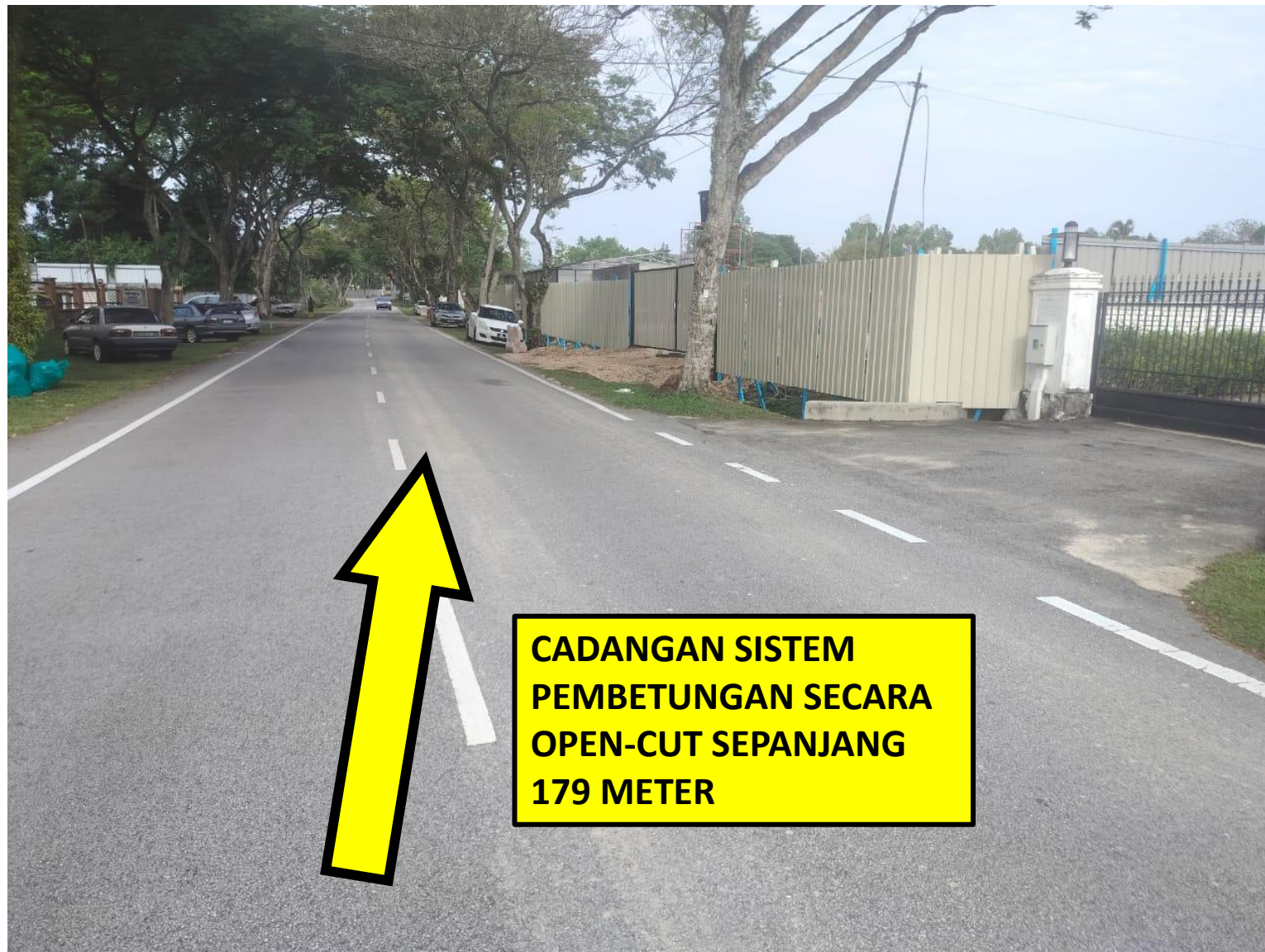
GAMBAR 4: KAWASAN KERJA MALIBATKAN KOREKAN JALAN BERTURAP
