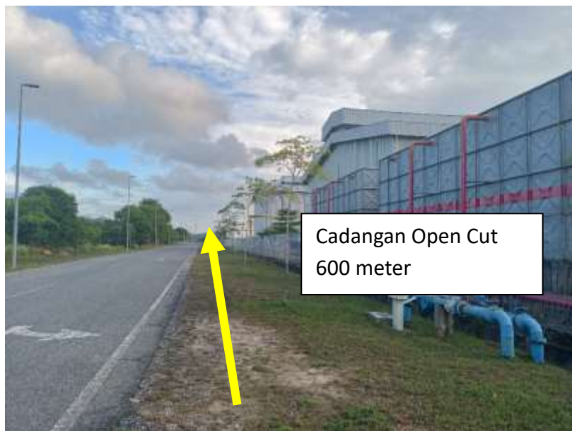
Gambar 8 : Kawasan Kerja Melibatkan Pemotongan Jalan (Open Cut)
