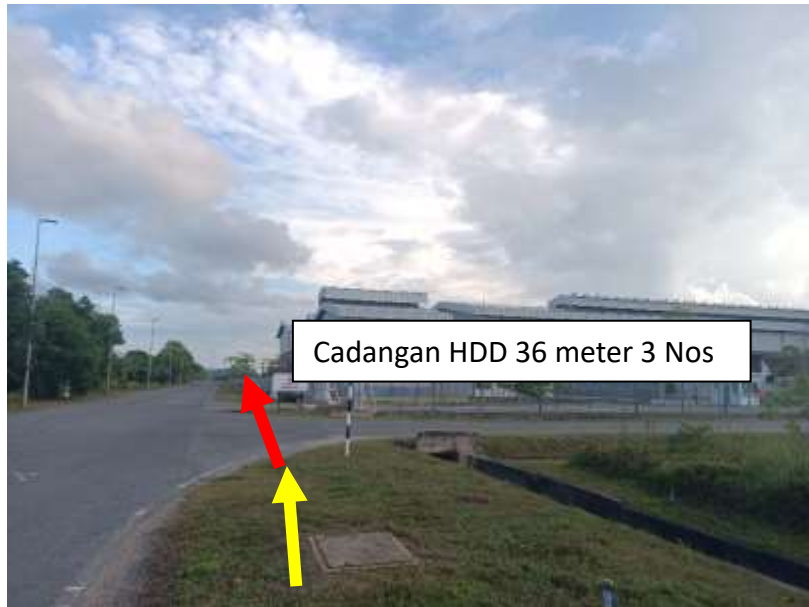
Gambar 5 : Kawasan Kerja Melibatkan Pematangan Jalan (Open Cut) dan ' Horizontal Directional Drilling'
