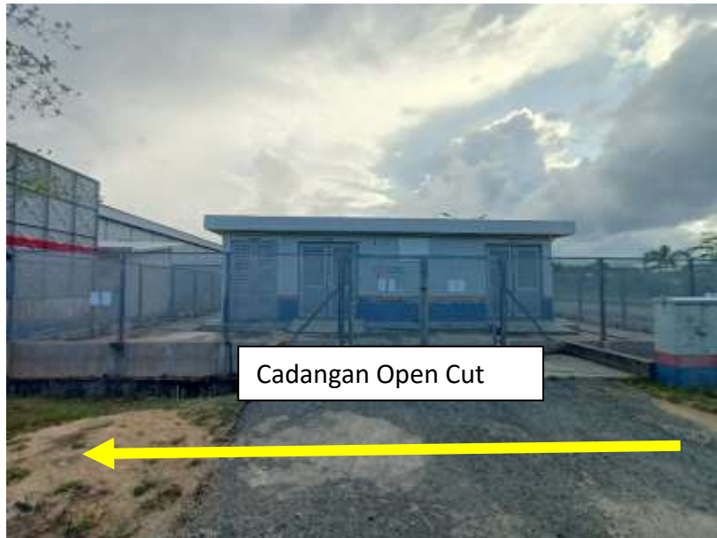
Gambar 7 : Kawasan Kerja Melibatkan Pemotongan Jalan (Open Cut)
