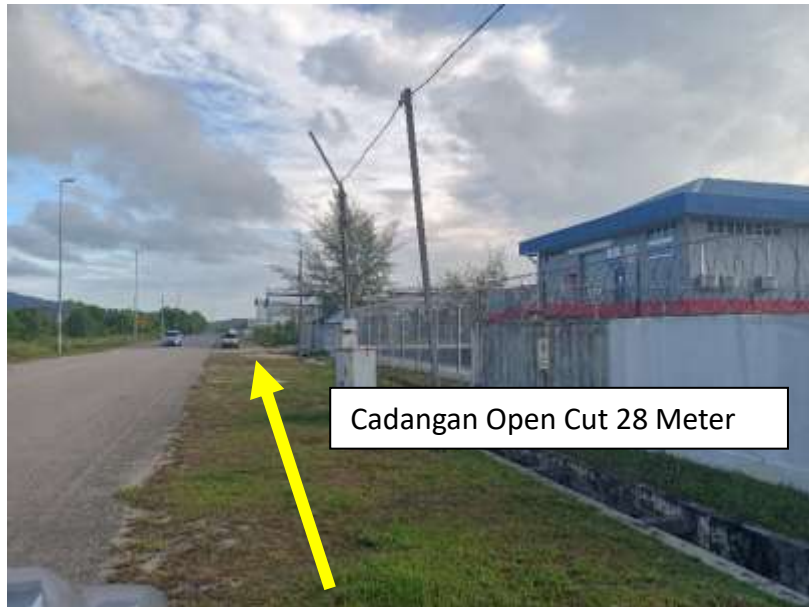
Gambar 3 : Kawasan Kerja Melibatkan Pemotongan Jalan (Open Cut)
