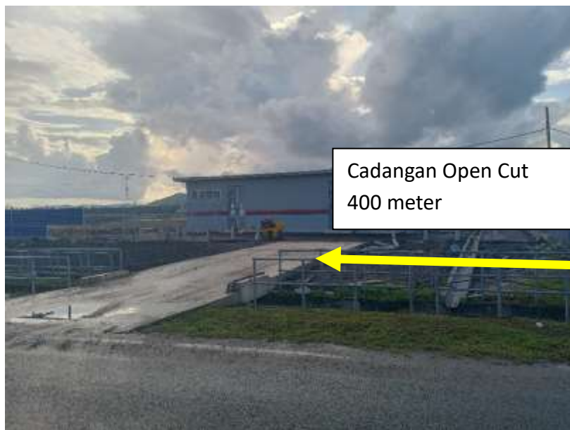
Gambar 12 : Kawasan Kerja Melibatkan Pemotongan Jalan (Open Cut)
