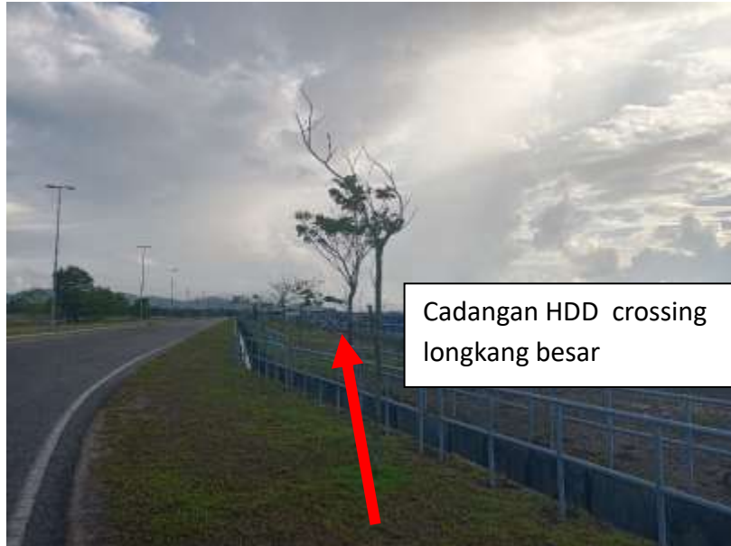
Gambar 11 : Kawasan Kerja melibatkan ' Horizontal Directional Drilling' crossing longkang besar 6 nos
