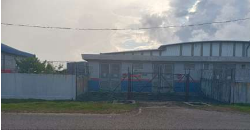
Gambar 1 : Pencawang Sediada 1 (Hi-Essence Substation)
