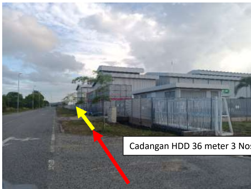
Gambar 6 : Kawasan Kerja Melibatkan Pematangan Jalan (Open Cut) dan ' Horizontal Directional Drilling'
