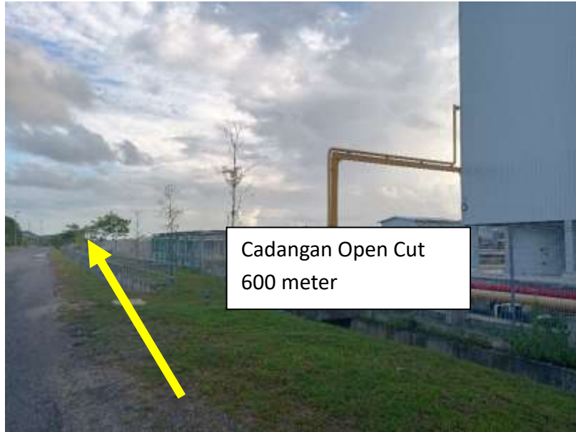
Gambar 9 : Kawasan Kerja Melibatkan Pemotongan Jalan (Open Cut)
