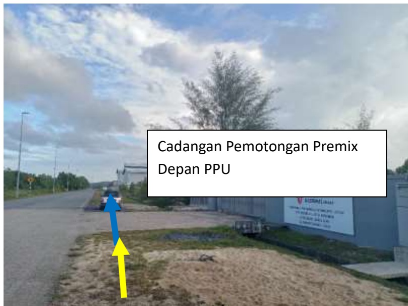
Gambar 4 : Kawasan Kerja Melibatkan Pemotongan Jalan dan Premix (Open Cut)
