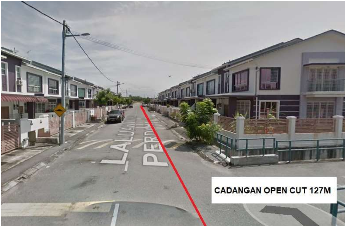
GAMBAR 2 : KAWASAN KERJA MELIBATKAN PEMOTONGAN JALAN (OPEN CUT)
