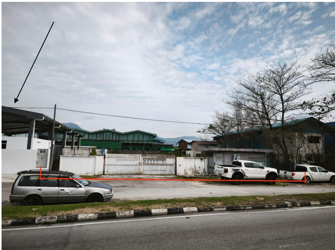
METER KIOSK BAGI LOT 111002 KE FEEDER PILLAR SEDIADA
