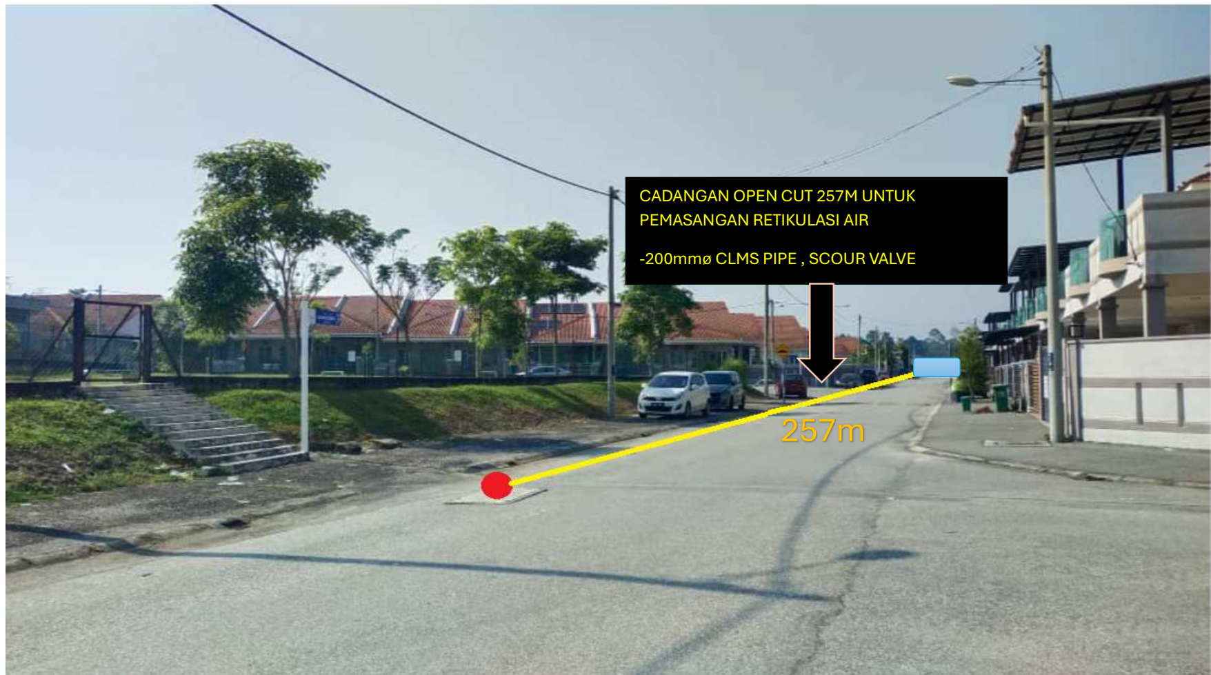
Gambar 2 : KAWASAN KERJA MELIBATKAN PEMOTONGAN JALAN (OPEN CUT) 257M UNTUK PEMASANGAN 200mmø CLMS PIPE DAN SCOUR VALVE
