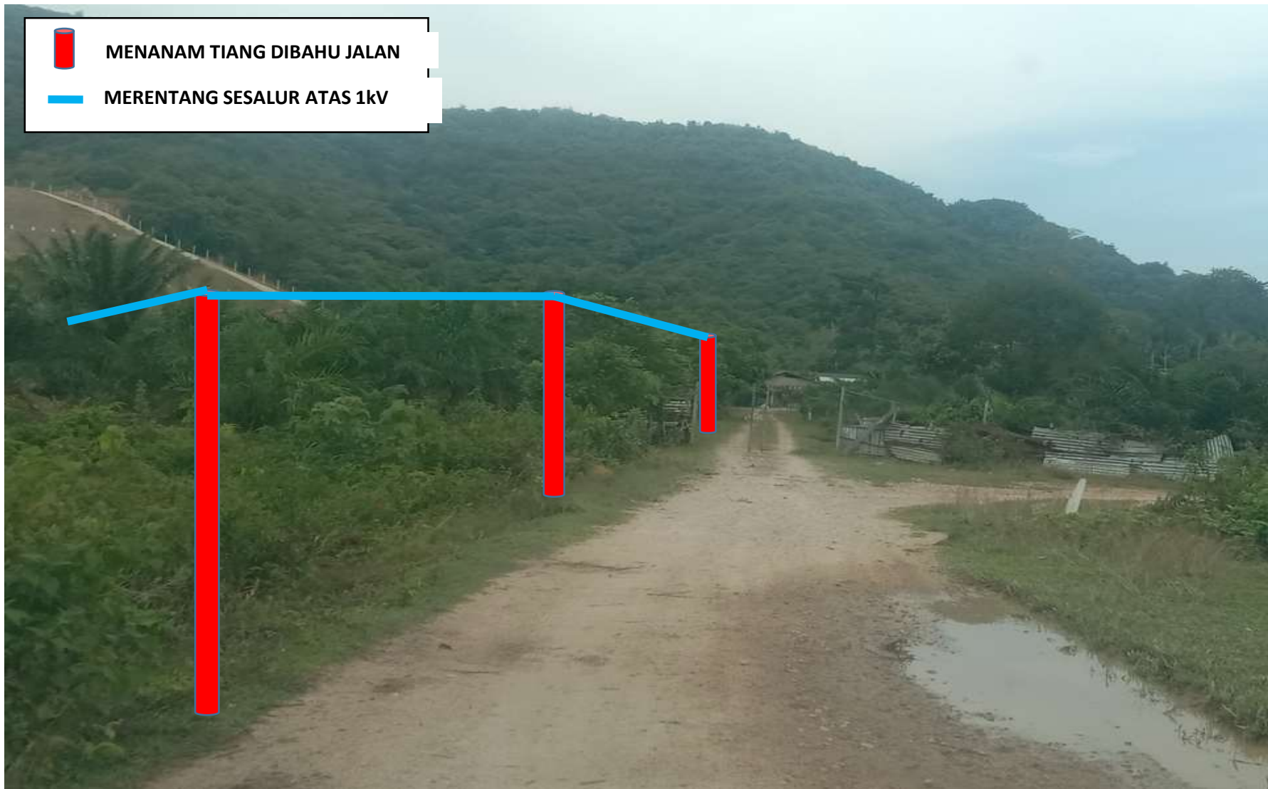
GAMBAR 6 : KAWASAN KERJA MENANAM TIANG 9.0M(2.0kN) DAN RENTANGAN SAVR BARU (AKHIR). (PELAN MSVR_2)
