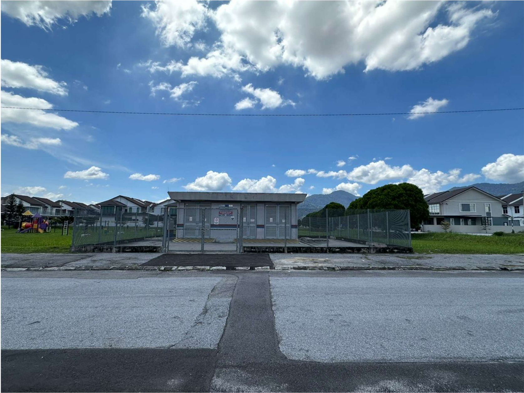
TAPAK PENCAWANG ELEKTRIK
