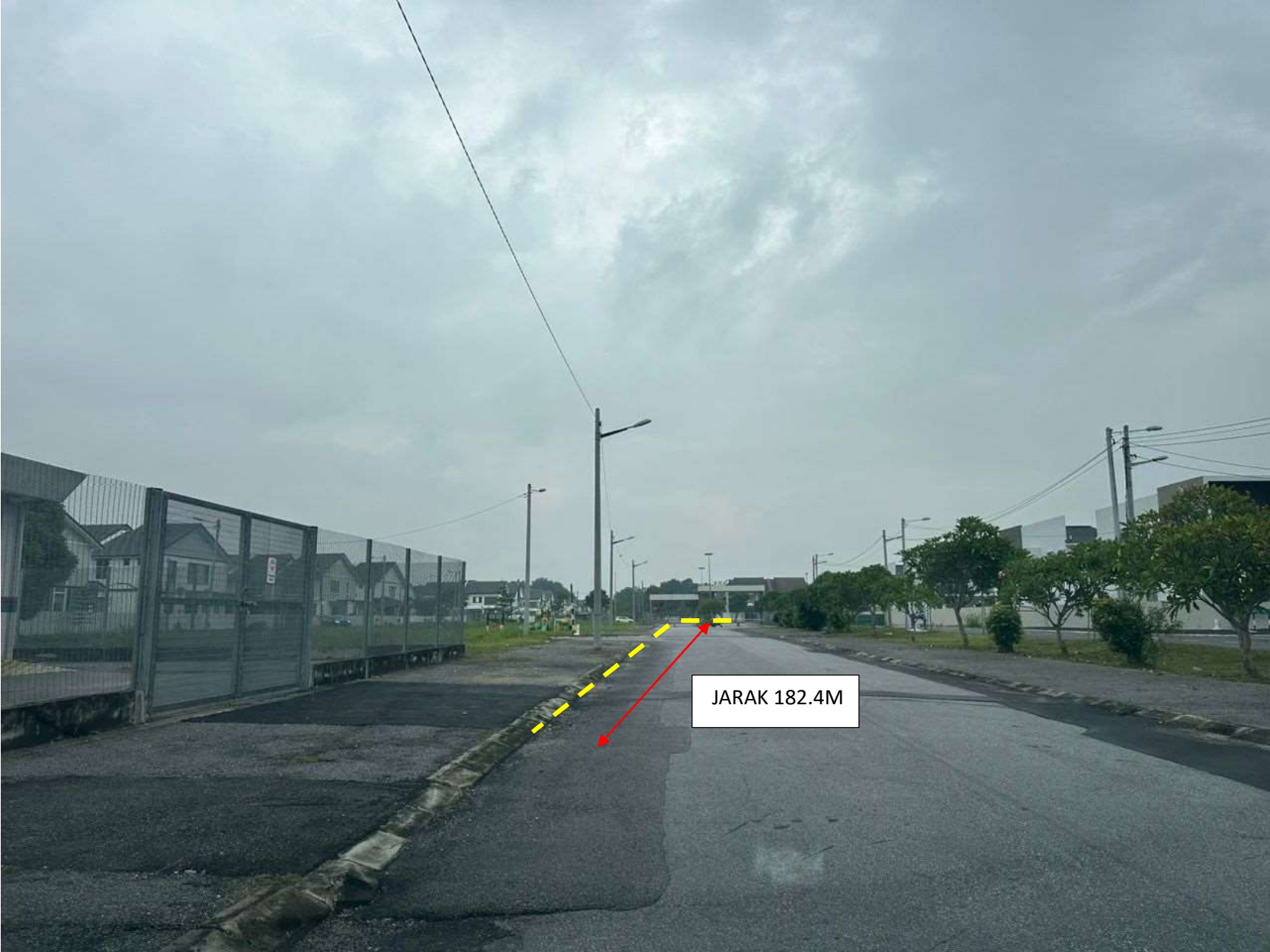
LOKASI CADANGAN KOREKAN DI JALAN SRI KLEBANG E/1
