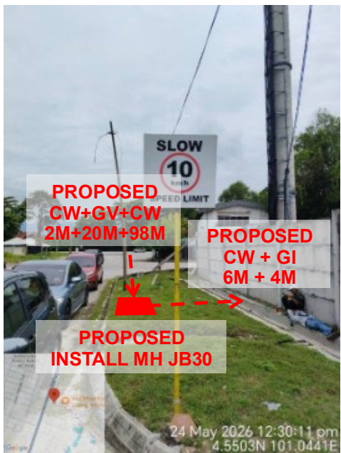
PICTURE 3 – Jalan Menglembu Impiana 21
