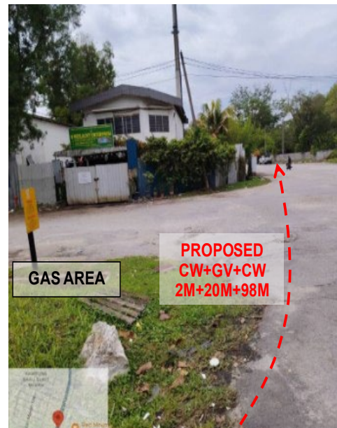
PICTURE 2 – Jalan Menglembu Impiana 2
