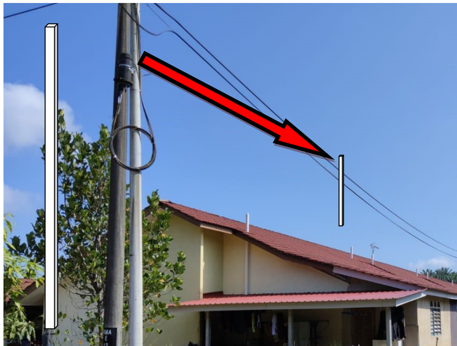
Contoh – Memasang tiang baru berdekatan tiang TM yang sedia ada.
