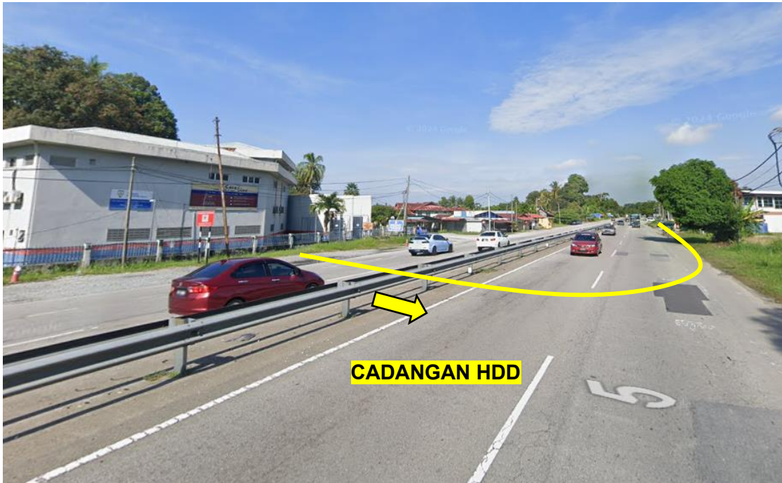
GAMBAR 1: KAWASAN KERJA MELIBATKAN 'HORIZONTAL DIRECTIONAL DRILLING'
