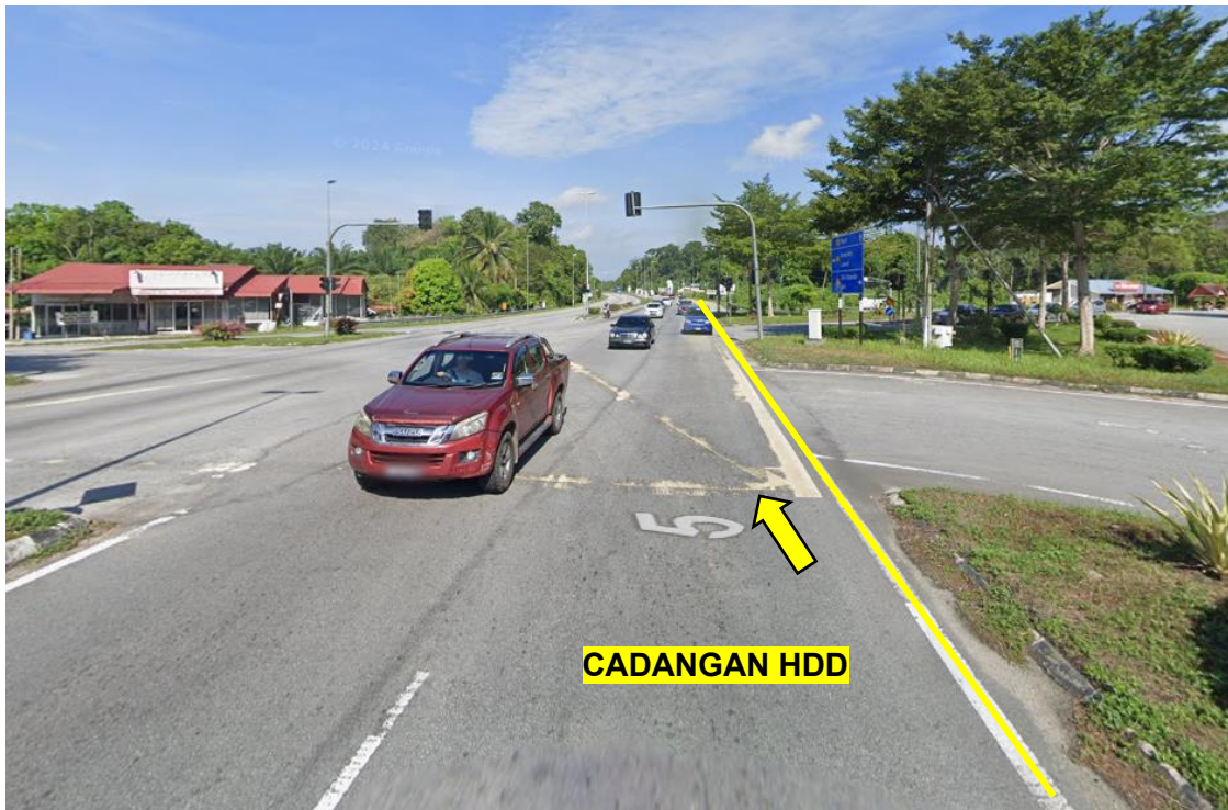
GAMBAR 2: KAWASAN KERJA MELIBATKAN 'HORIZONTAL DIRECTIONAL DRILLING'
