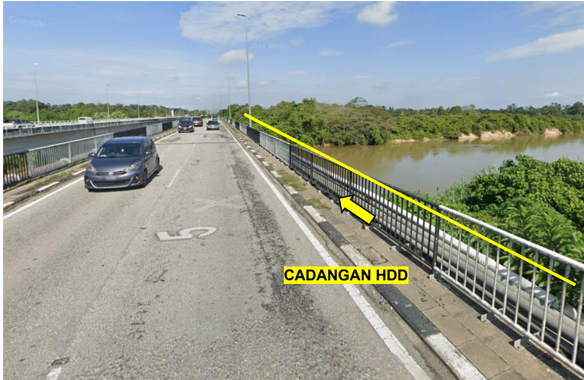
GAMBAR 3: KAWASAN KERJA MELIBATKAN 'HORIZONTAL DIRECTIONAL DRILLING'
