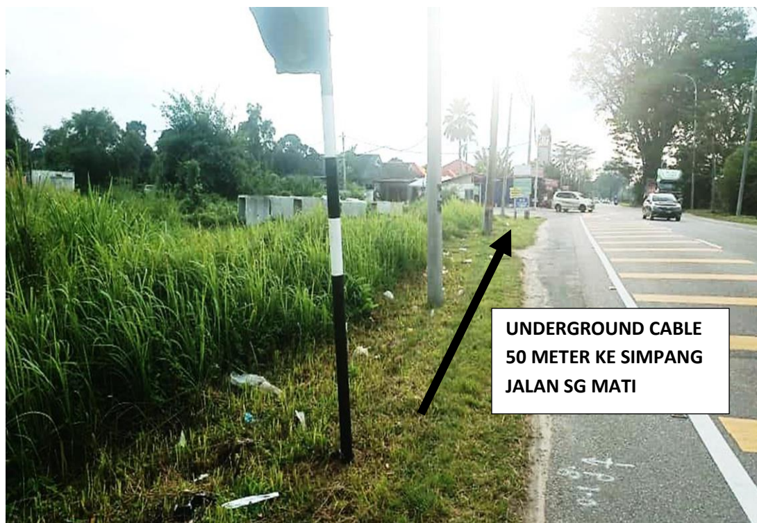
GAMBAR 2 : KAWASAN KERJA UNTUK PENGALIHAN TIANG DAN TALIAN MELIBATKAN LALUAN REZAB JALAN JKR
