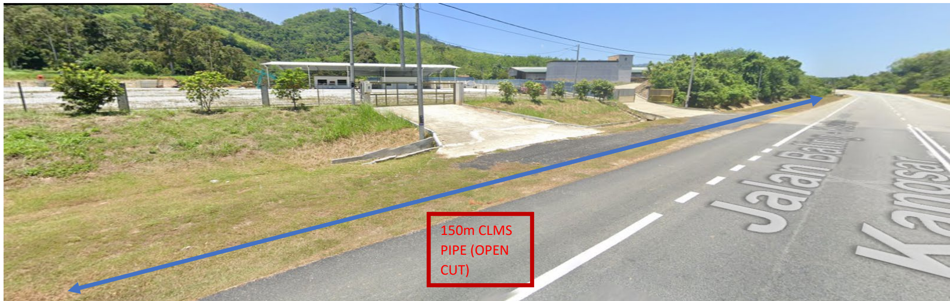
LOKASI PEMASANGAN PAIP JALAN BALING-KUALA KANGSAR
