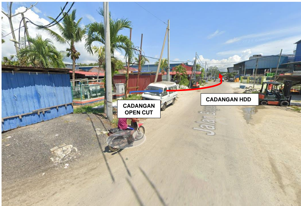
GAMBAR 2: KAWASAN KERJA MELIBATKAN PEMOTONGAN JALAN (OPEN CUT) DAN 'HORIZONTAL DIRECTIONAL DRILLING'
