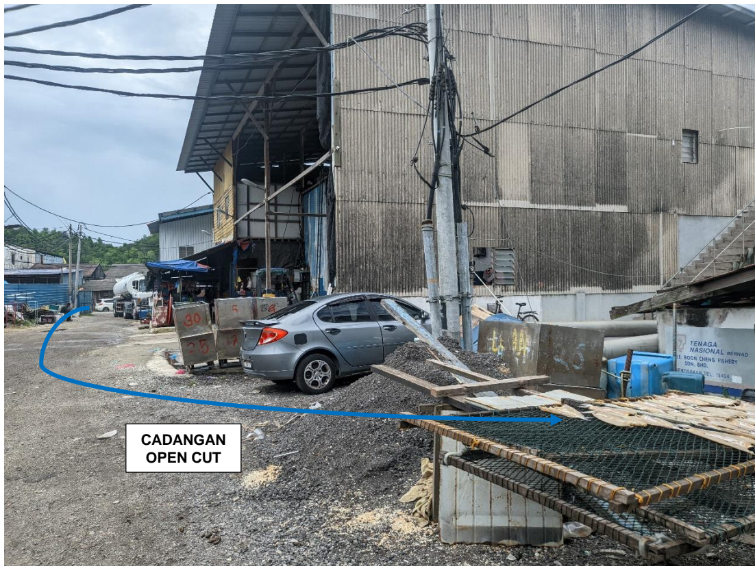
GAMBAR 4: KAWASAN KERJA MELIBATKAN PEMOTONGAN JALAN (OPEN CUT)
