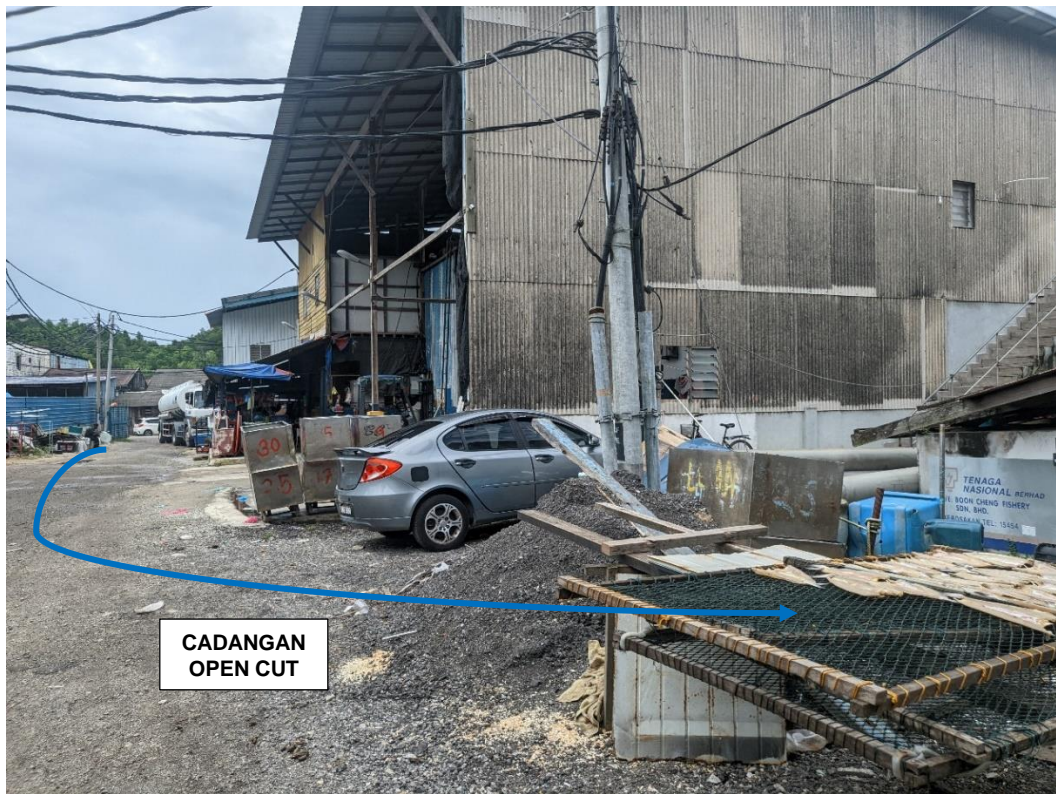
GAMBAR 3: KAWASAN KERJA MELIBATKAN PEMOTONGAN JALAN (OPEN CUT)
