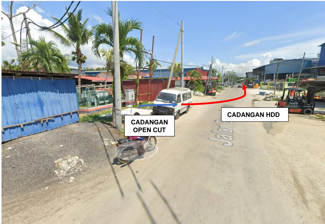
GAMBAR 1: KAWASAN KERJA MELIBATKAN PEMOTONGAN JALAN (OPEN CUT) DAN 'HORIZONTAL DIRECTIONAL DRILLING'
