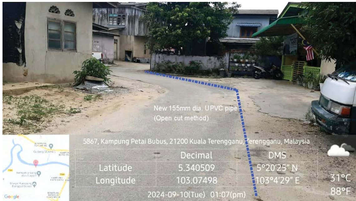
GAMBAR 3 : Kawasan cadangan laluan paip baru pada laluan jalan.
