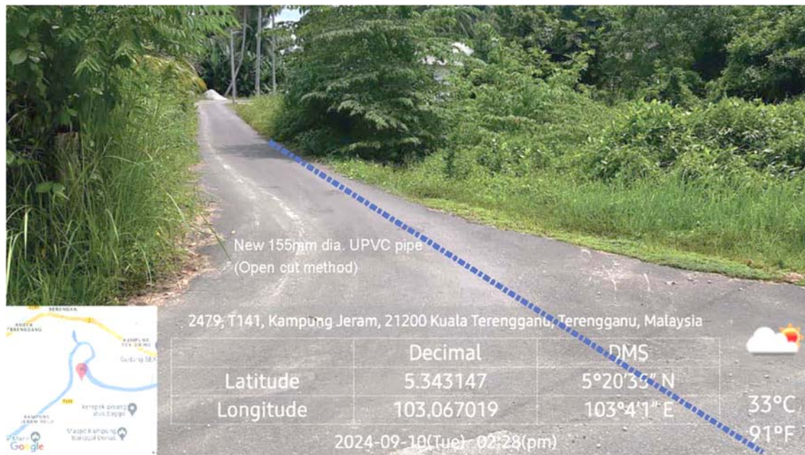
GAMBAR 7 : Kawasan cadangan laluan paip baru pada laluan jalan.
