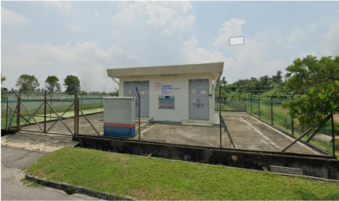
Gambar 1 : Pencawang Elektrik Sediaada (Taman Mutiara Indah)
