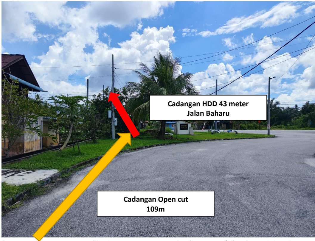
Gambar 3 : Kawasan Kerja melibatkan pemotongan jalan (Open Cut) di Jalan Indah 1 & Horizontal Directional Drilling
