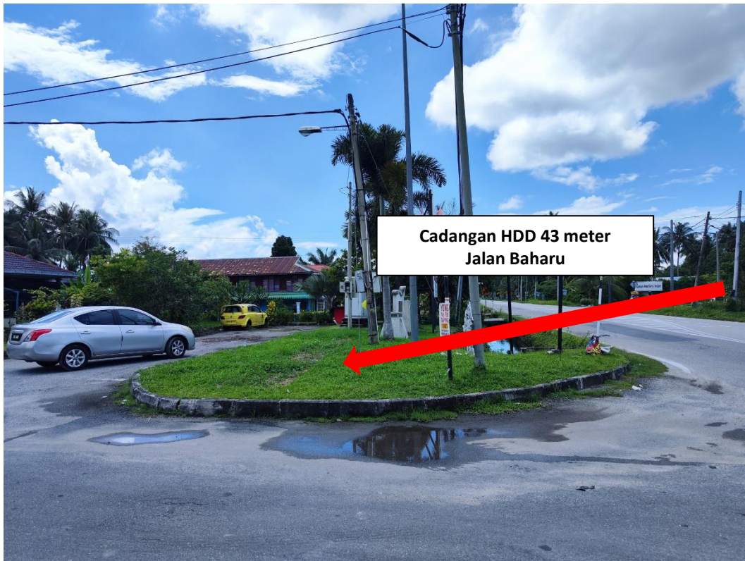
Gambar 4 : Kawasan Kerja melibatkan Horizontal Directional Drilling
