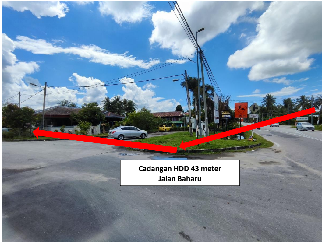
Gambar 5 : Kawasan Kerja melibatkan Horizontal Directional Drilling
