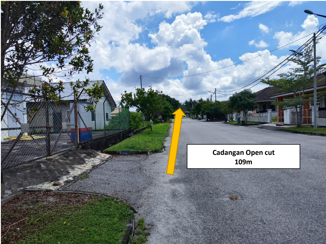
Gambar 2 : Kawasan Kerja melibatkan pemotongan jalan (Open Cut) di Jalan Indah 1
