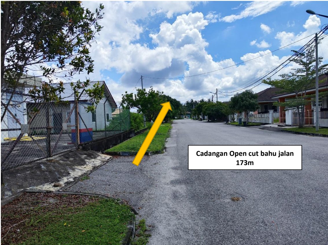
Gambar 2 : Kawasan Kerja melibatkan pemotongan bahu jalan (Open Cut) di Jalan Indah 1
