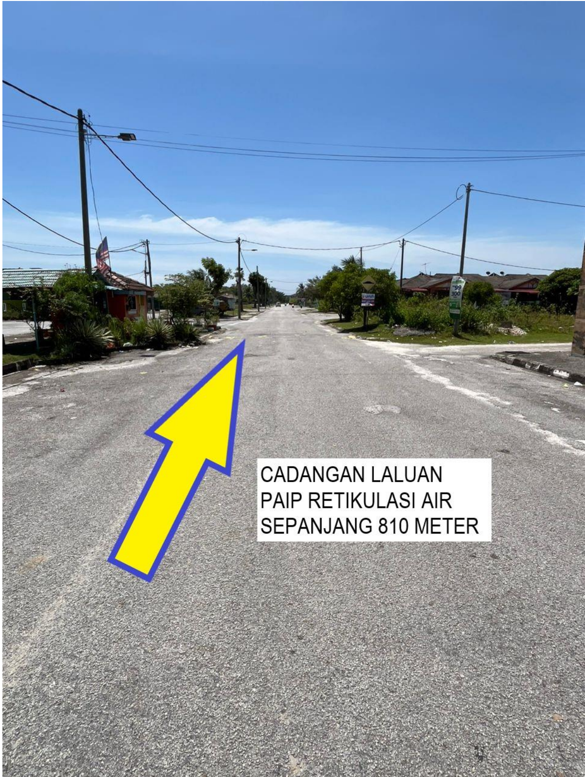
GAMBAR 1: KAWASAN KERJA MALIBATKAN KOREKAN JALAN BERTURAP
