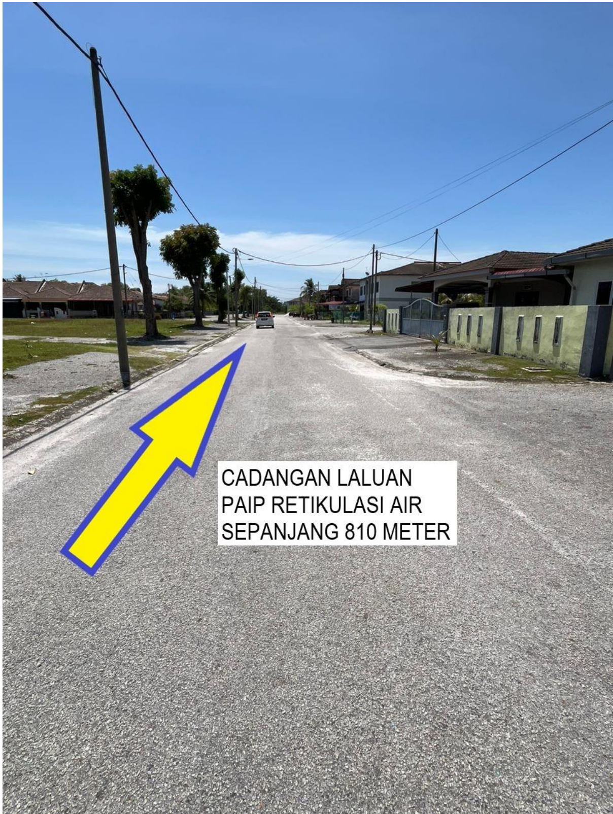
GAMBAR 2: KAWASAN KERJA MALIBATKAN KOREKAN JALAN BERTURAP
