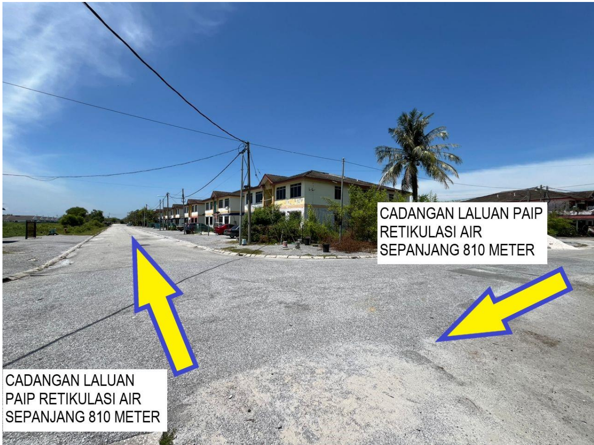
GAMBAR 3: KAWASAN KERJA MALIBATKAN KOREKAN JALAN BERTURAP
