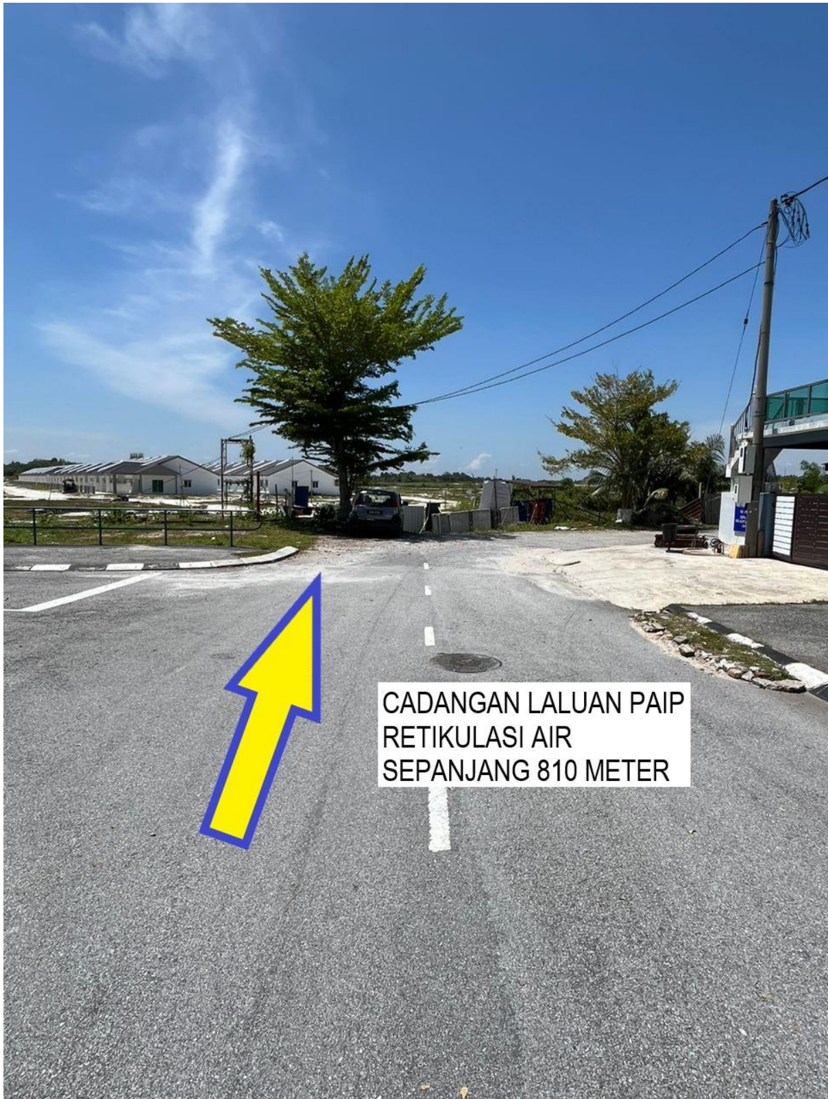
GAMBAR 5: KAWASAN KERJA MALIBATKAN KOREKAN JALAN BERTURAP
