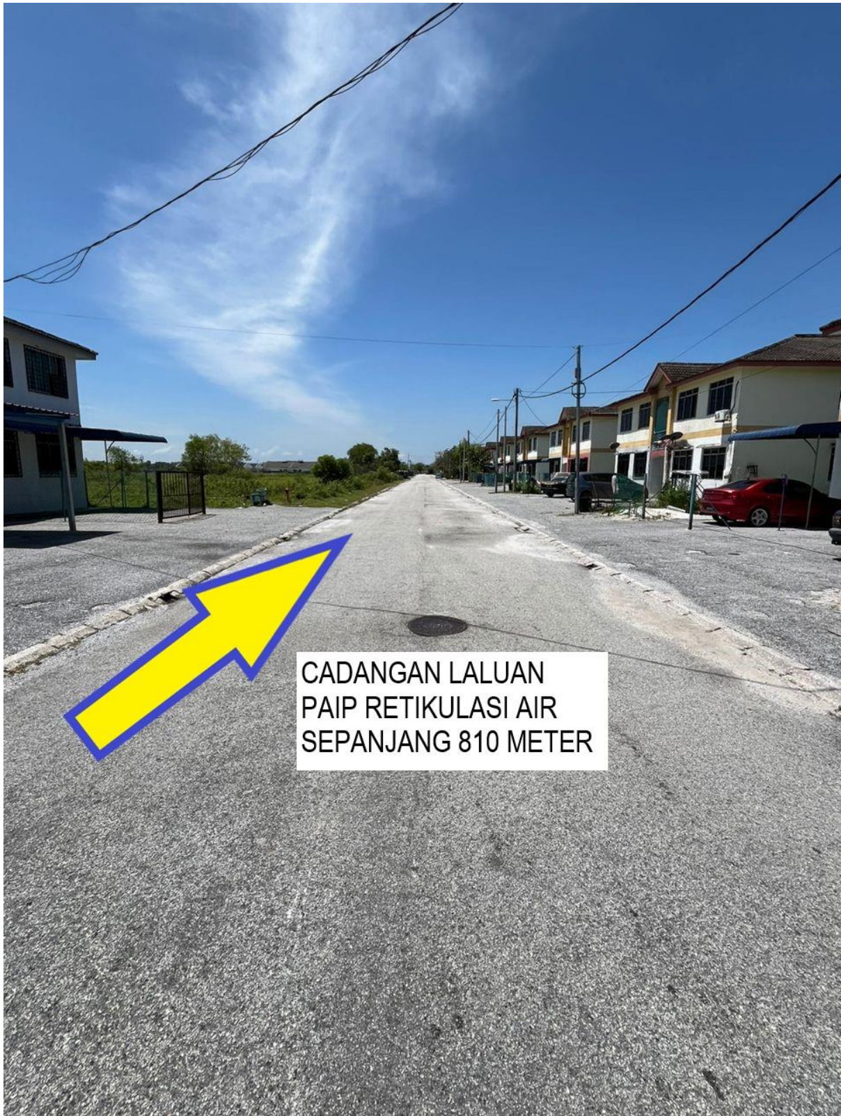
GAMBAR 4: KAWASAN KERJA MALIBATKAN KOREKAN JALAN BERTURAP
