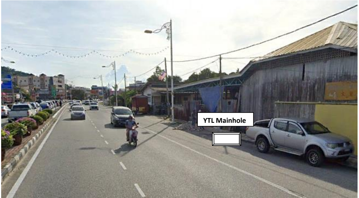
Laluan kiri jalan – YTL mainhole
