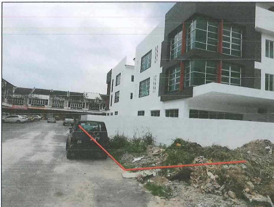
KABEL KEPADA TNB COMPACT SUB
