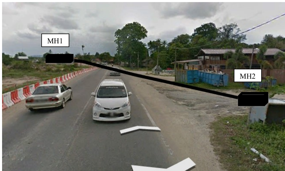
HDD – Menyeberang Jalan MH1 - 4.237197° 103.387917° MH2 - 4.237531° 103.388395°
