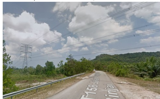
2) HDD - TNB PYLON
