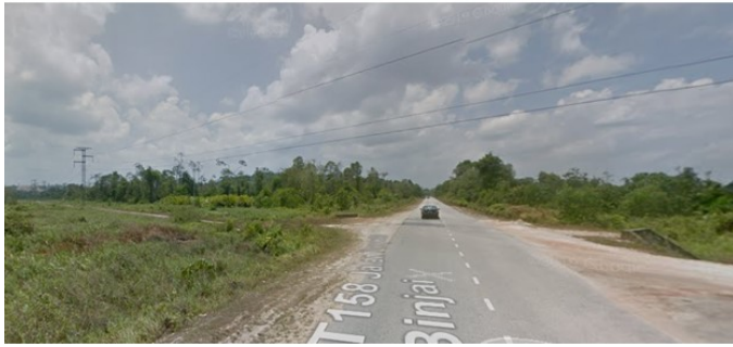
HDD - TNB PYLON
