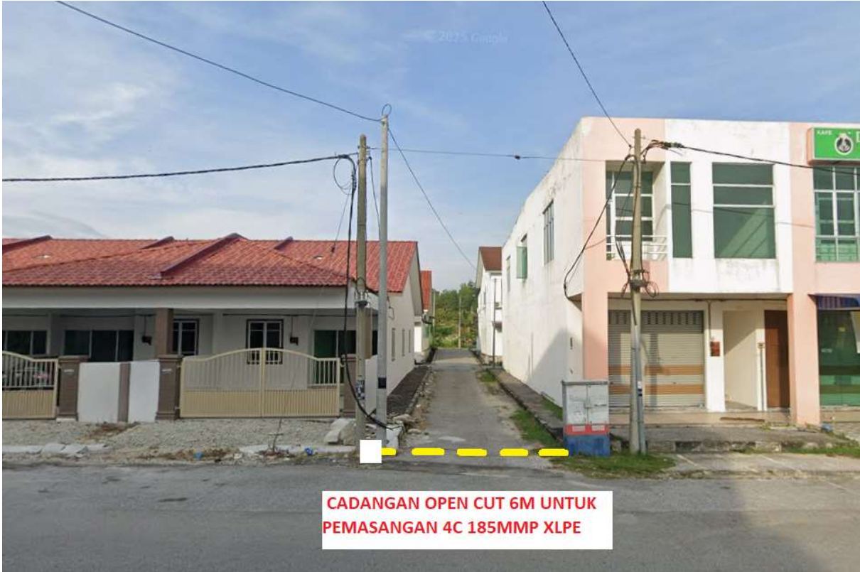
Gambar 2 : Kawasan Kerja Melibatkan Pemotongan Jalan (Open Cut)
