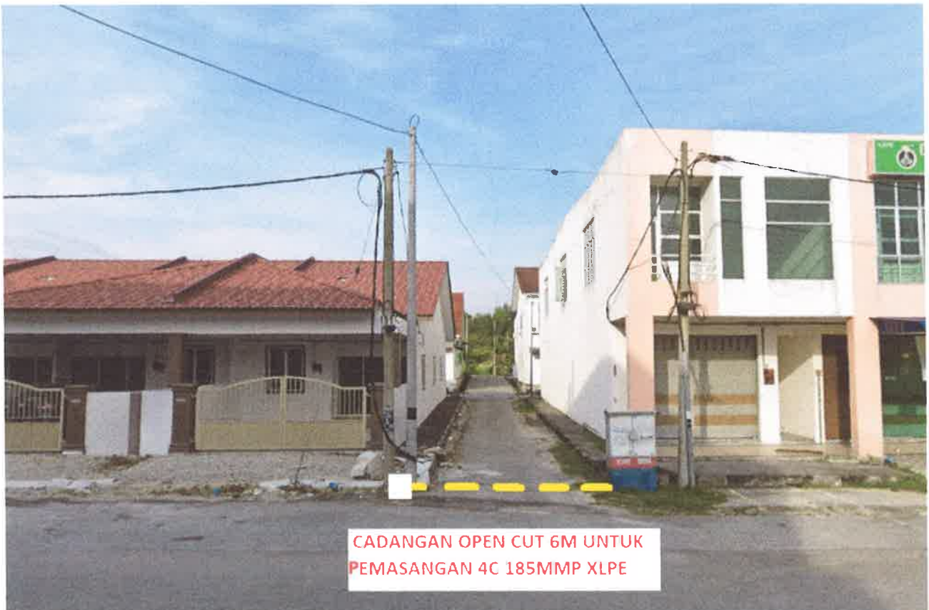
Gambar 2 : Kawasan Kerja Melibatkan Pemojangan Jalan (Open Cut)
