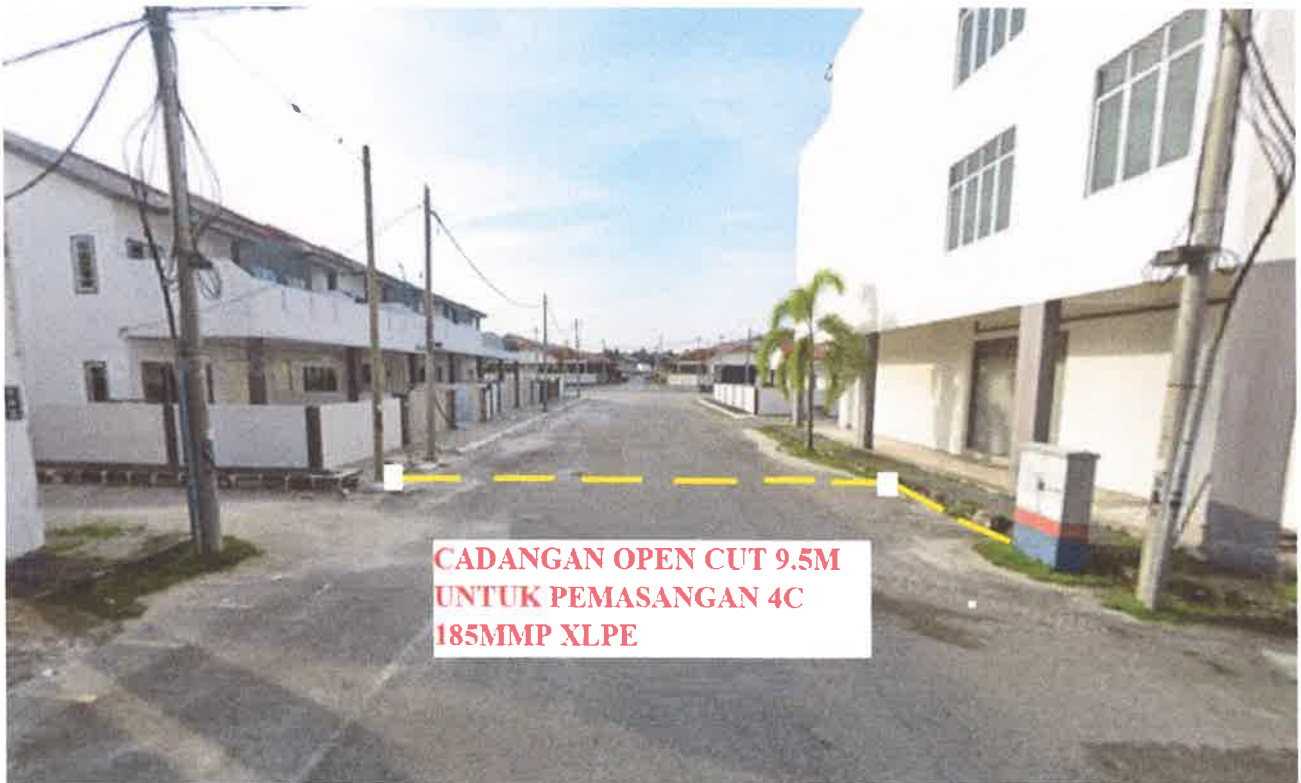
Gambar 4 : Kawasan Kerja Melibatkan Pemotongan Jalan (Open Cut)
