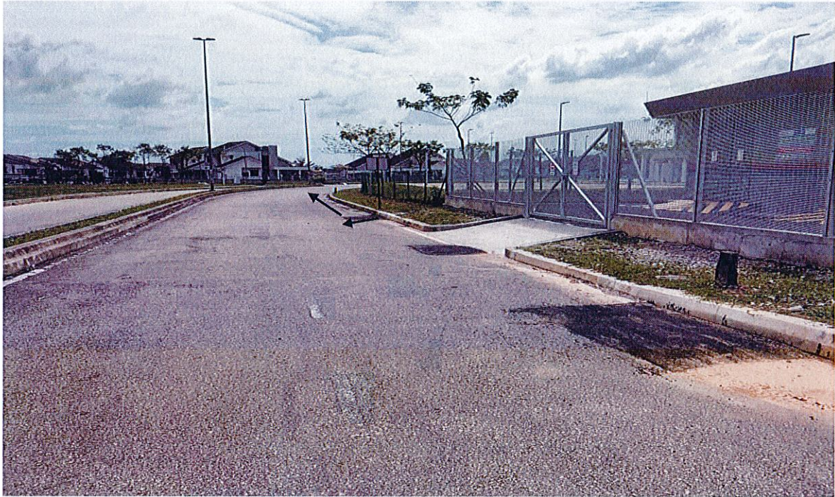
3- Laluan kerja-kerja korekan jalan CAD.U/G XLPE 300mmp, 4C, 1KV
