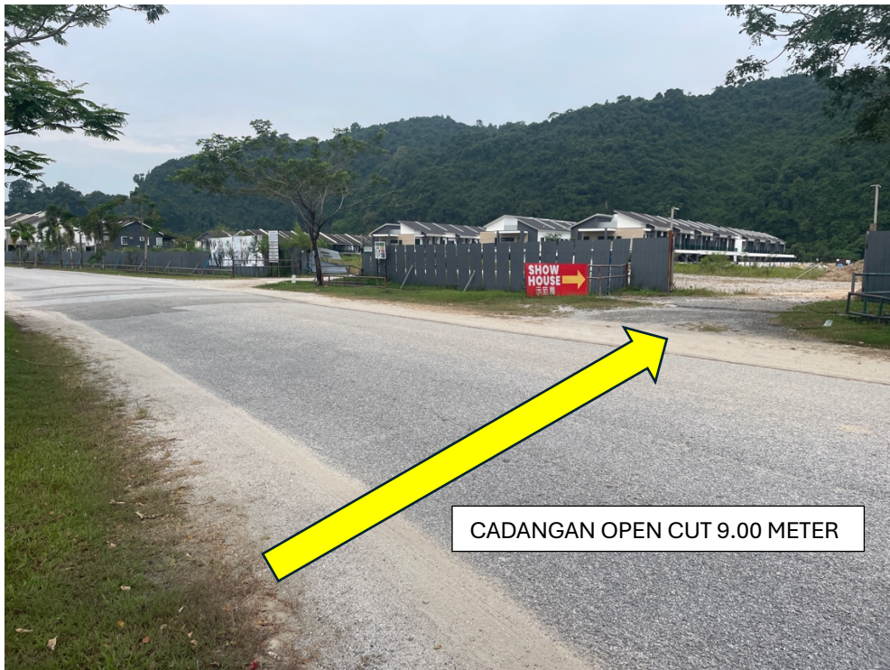
GAMBAR 2 : KAWASAN KERJA YANG MELIBATKAN PEMOTONGAN JALAN SECARA OPEN CUT
