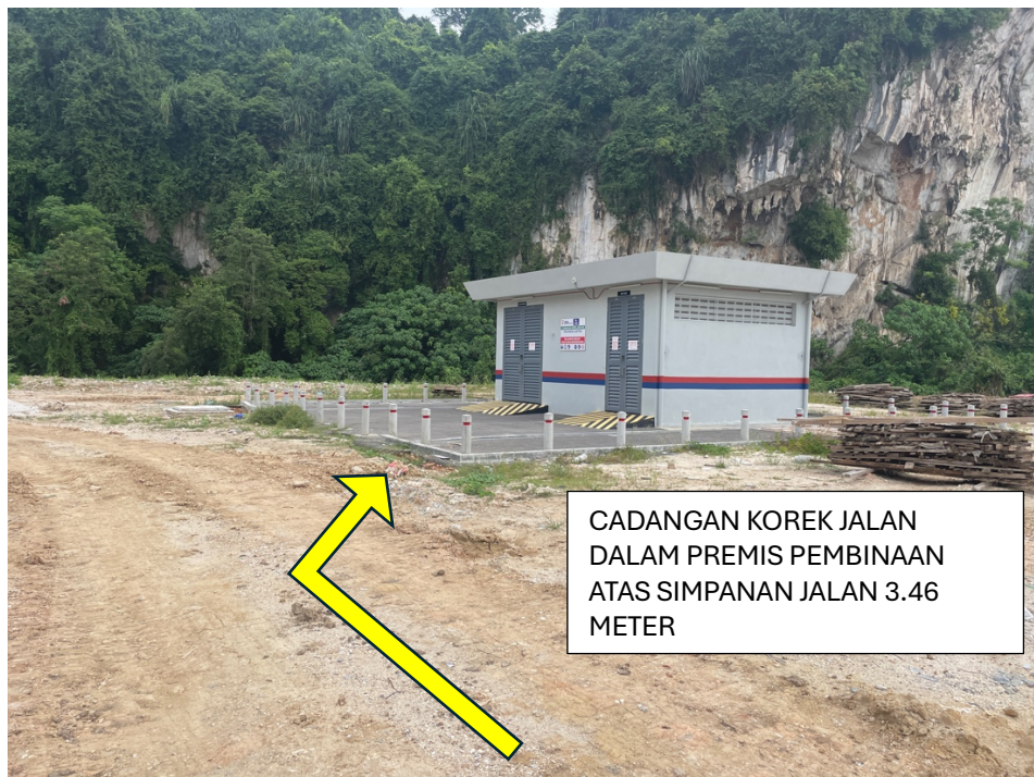
GAMBAR 8 : KAWASAN KERJA YANG MELIBATKAN PENGOREKKAN JALAN (DALAM PREMIS TAPAK PEMBINAAN DI ATAS SIMPANAN JALAN) TERUS KE PENCAWANG ELEKTRIK BARU
