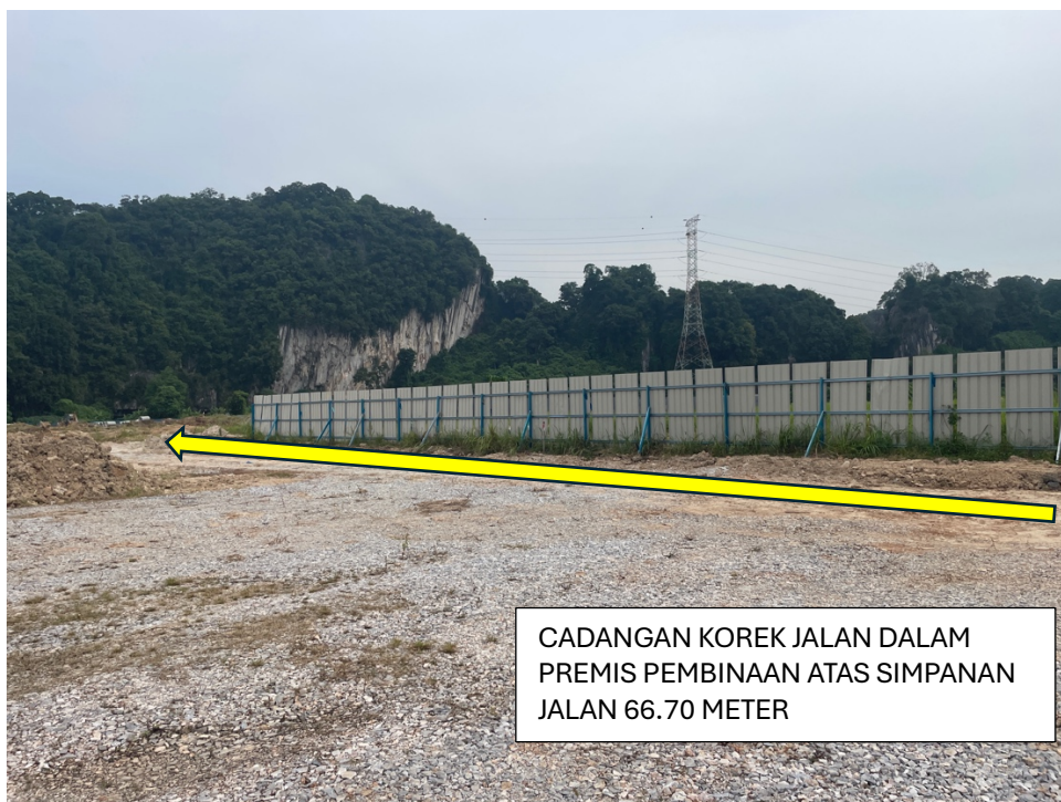
GAMBAR 4 : KAWASAN KERJA YANG MELIBATKAN PENGOREKKAN JALAN (DALAM PREMIS TAPAK PEMBINAAN DI ATAS SIMPANAN JALAN)
